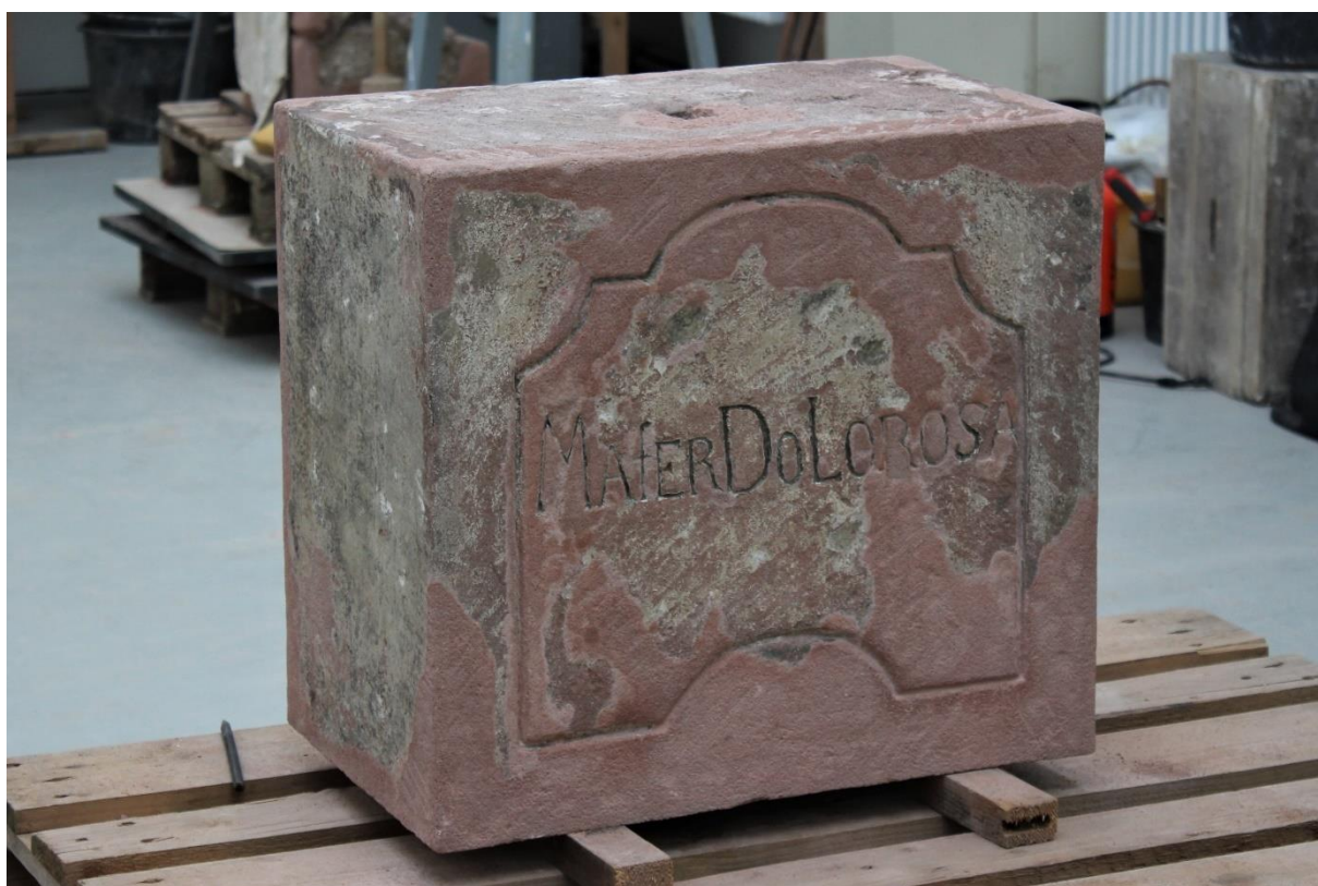
Obr. č. 59. Dokončené plastické retuše na dříku soklu
