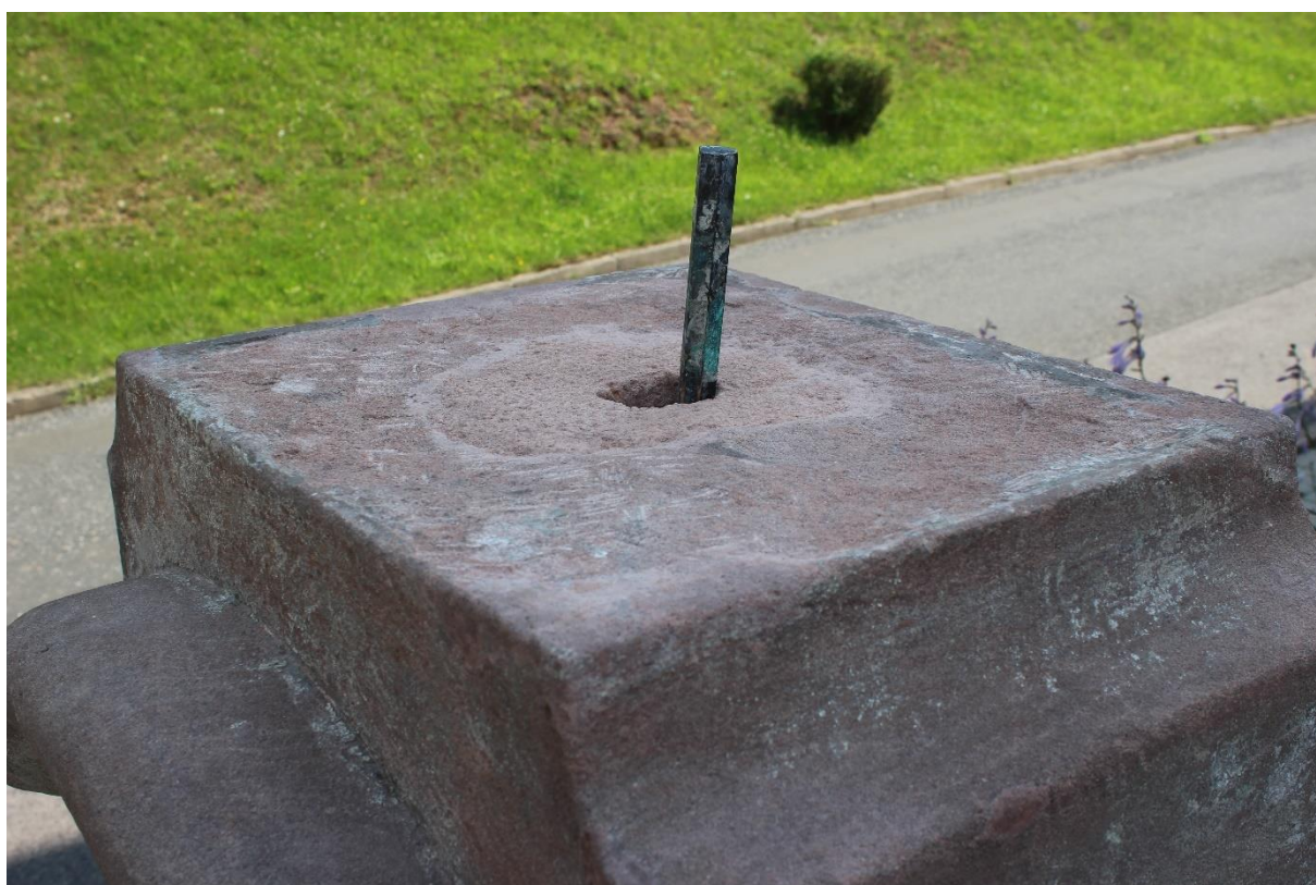
Obr. č. 84. Čep v hlavici podstavce, vsazen na suchou vápenocementovou směs
