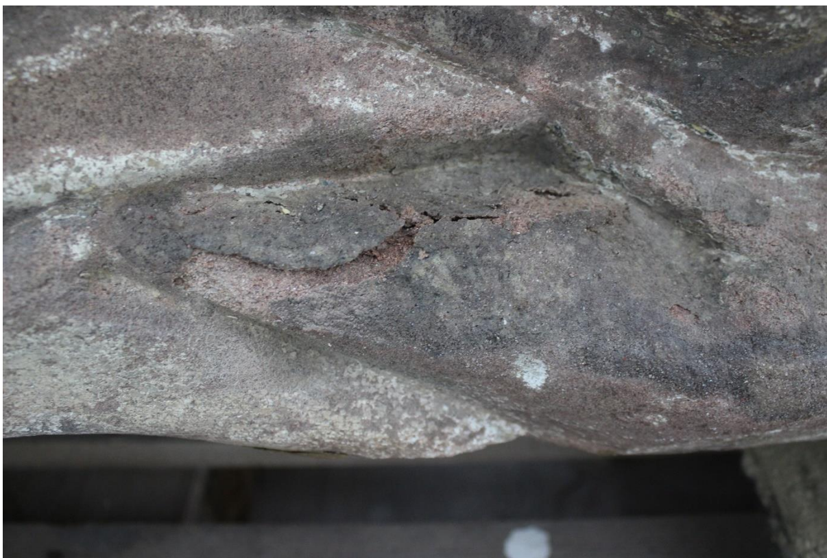
Obr. č. 17. Zde byly odebrány vzorky pro stanovení obsahu vodorozpustných solí
