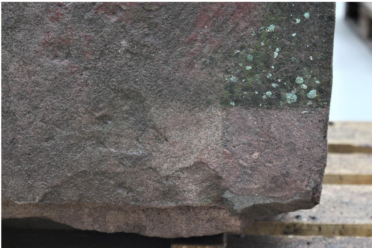
Obr. č. 26. Odstranění biologického napadení na patce soklu – zkouška čištění parním čističem
