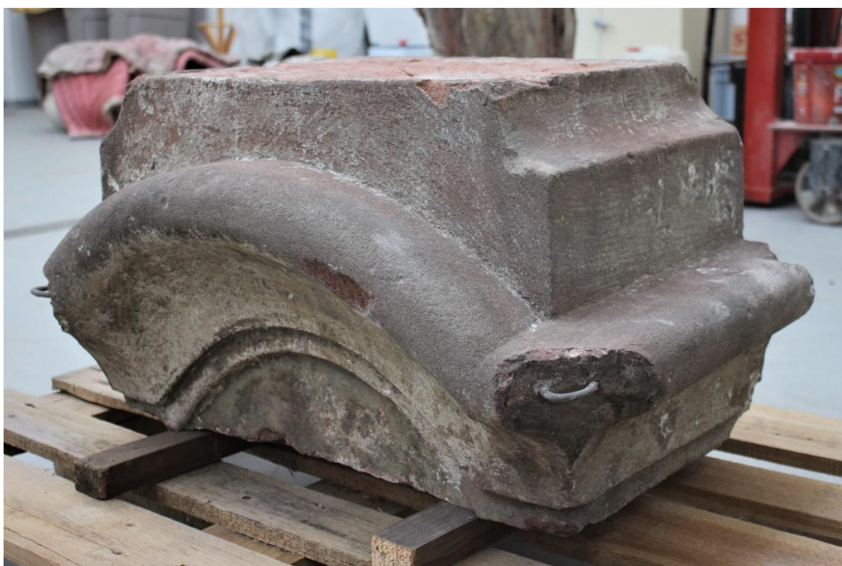
Obr. č. 32. Po odstranění nevhodných tmelů
