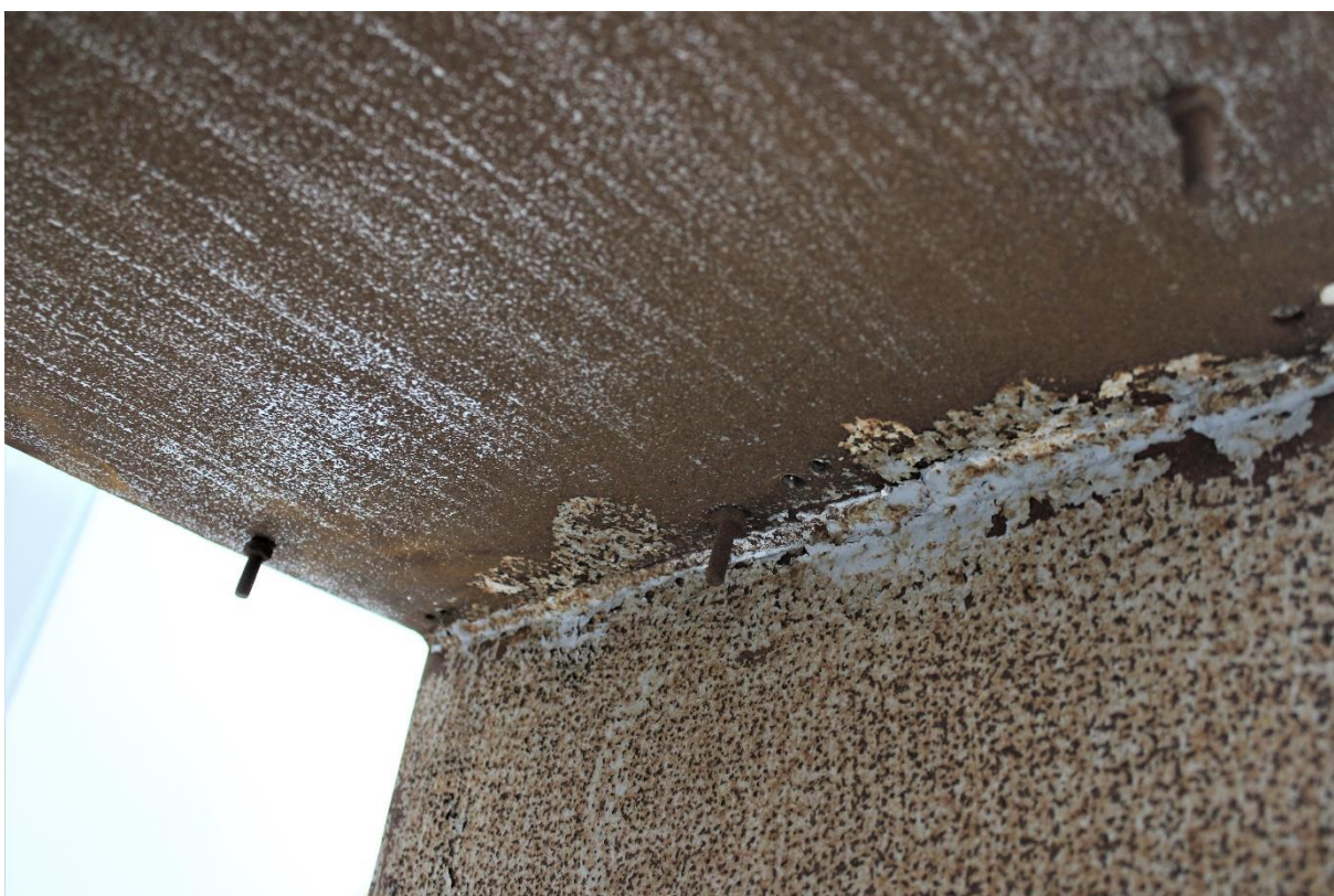
Obr. č. 26. Těmito třemi šrouby je socha připevněna k podstavci
