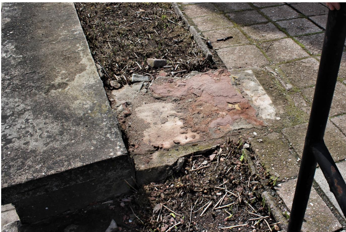
Obr. č. 81. Před úpravou betonového základu
