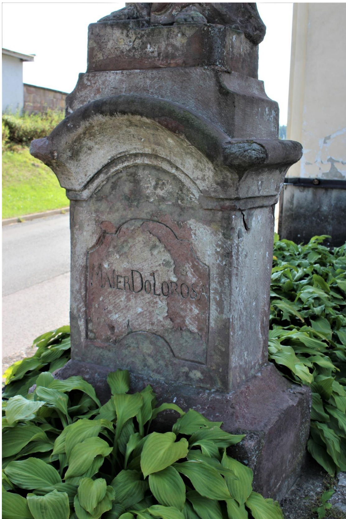
Obr. č. 7. Pohled z tříčtvrtky na sokl
