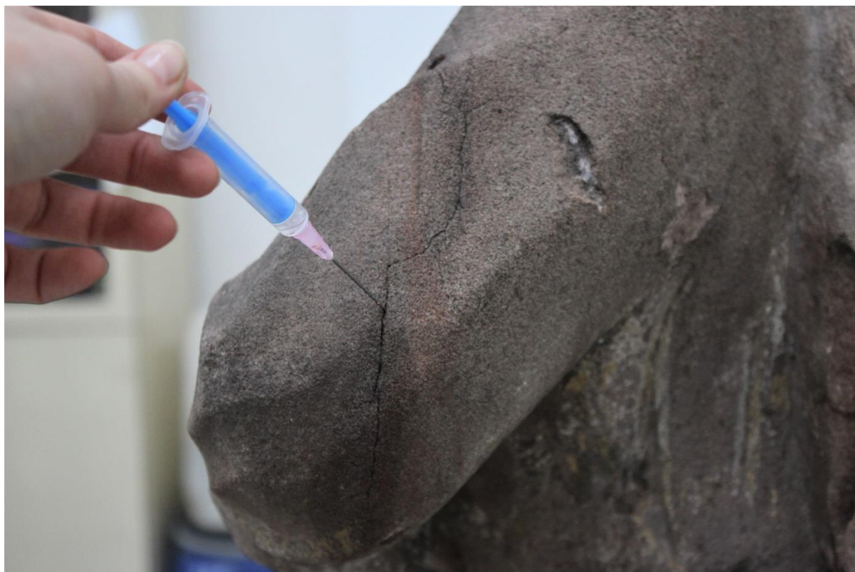
Obr. č. 41. Průběh injektování
