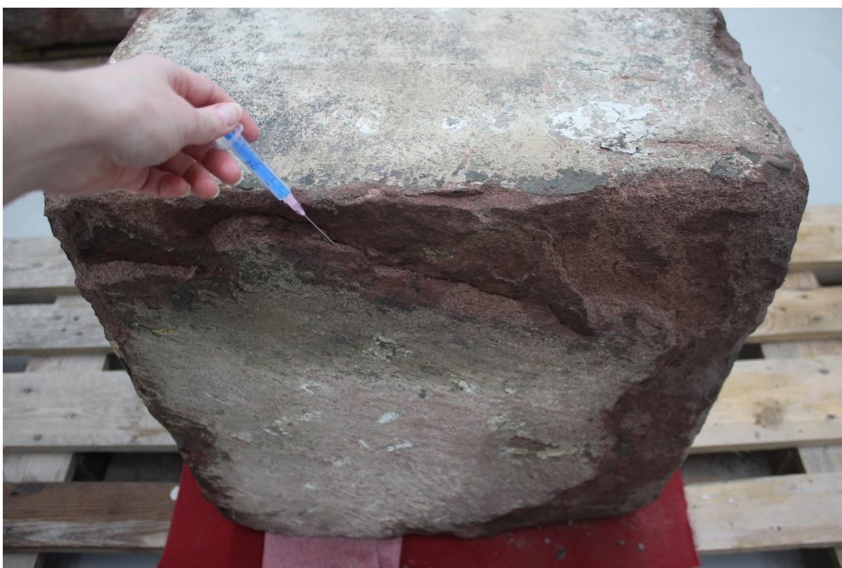
Obr. č. 44. Injektování do prasklin v soklu
