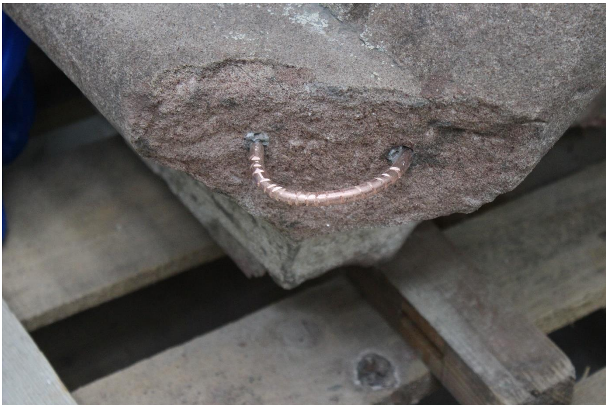
Obr. č. 33. Očištěná a nařezaná armatura
