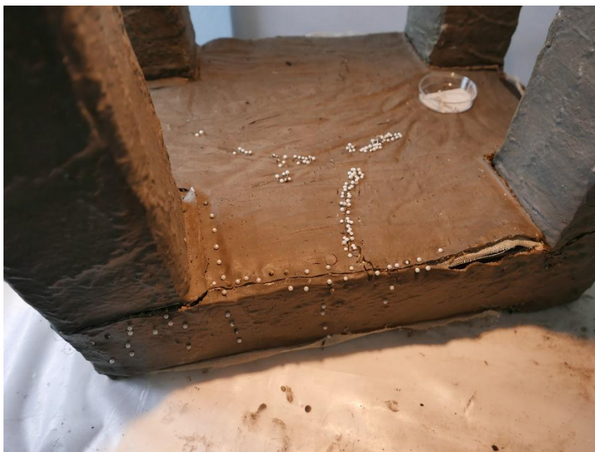
Obr. č. 102 Detail lepení a kotvení prasklin a sekundárních řezů
