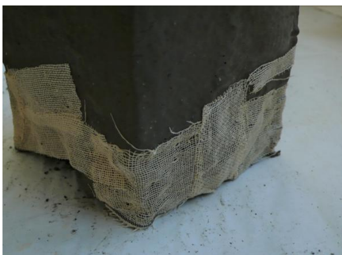
Organtýnové přelep pro fixaci povrchu
