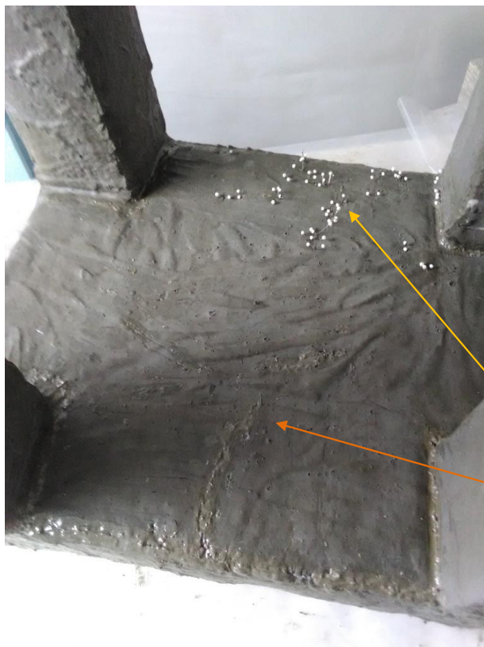
Obr. č. 104 Scelování a tmelení prasklin
