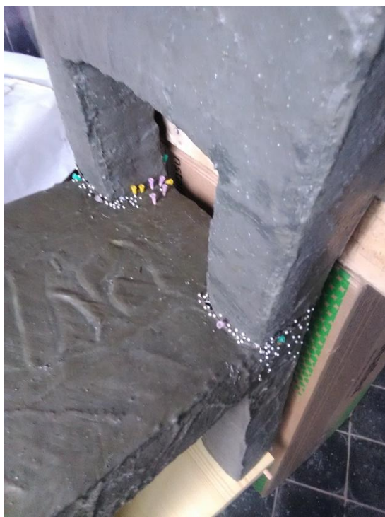
Obr. č. 108 a; b Lepení opěradla k sedací části
