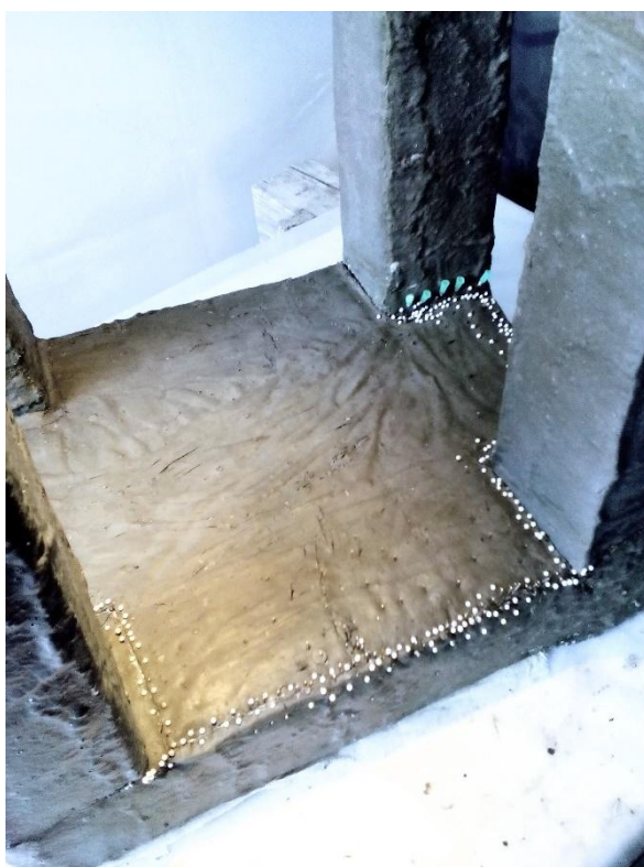
Obr. č. 103 Lepení a kotvení sekundárních řezů
