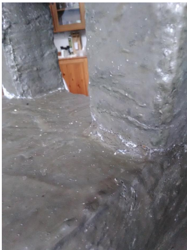
a Doplňování hmoty spoje, tmelení
