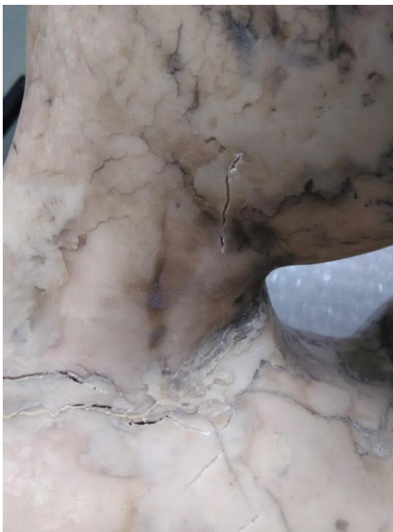
Obr. č. 104 a 105 Detaily prasklin
