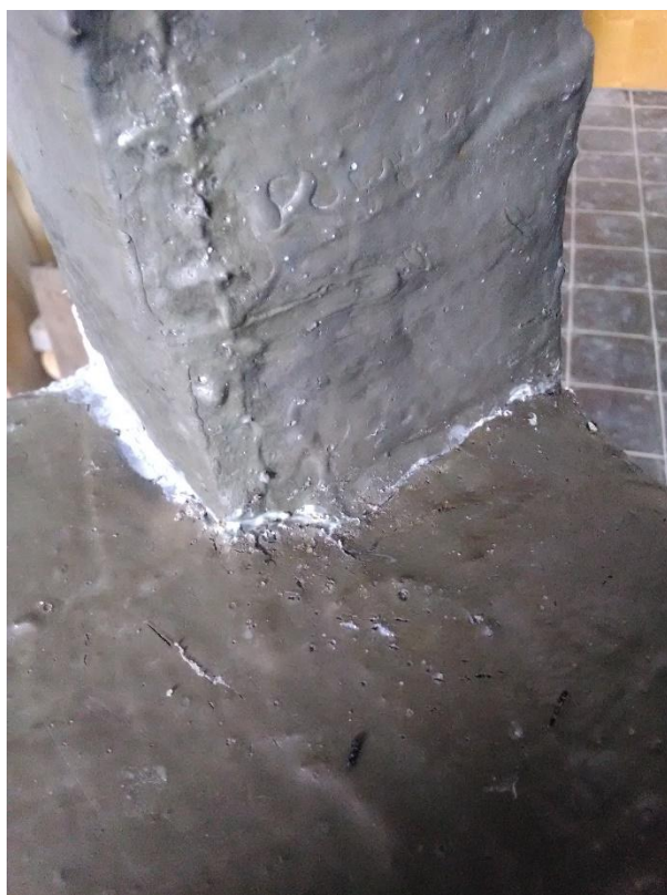
c Doplnění hmoty spoje, tmelení
