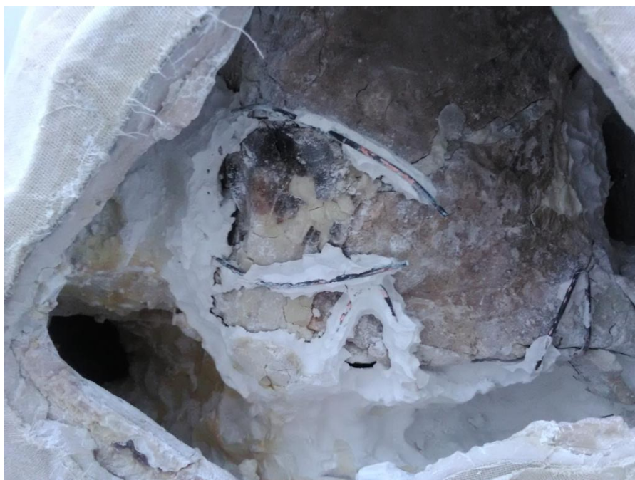
Obr. č. 94 Detail odkryté části armování
