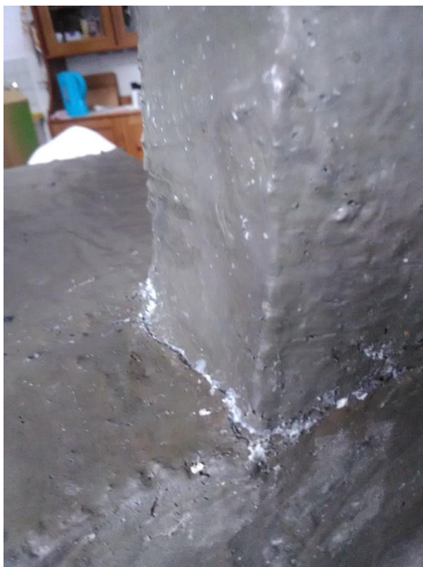
b Doplnění hmoty spoje, tmelení
