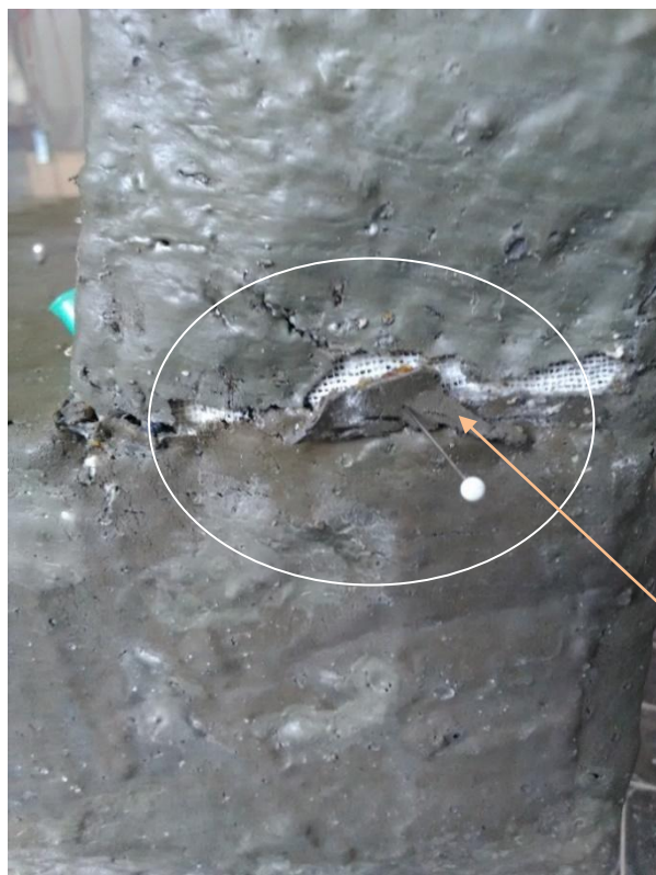
b Rekonstrukce chybějících částí
