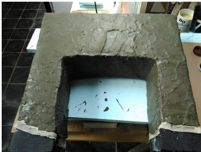
Obr. č. 111 Retuš během práce, položení prvního základu
