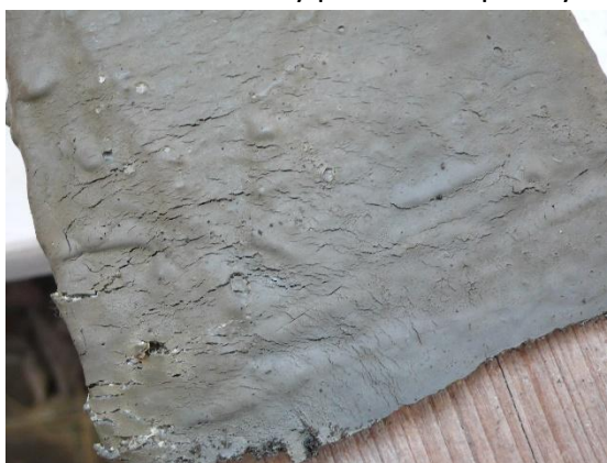
Obr. č. 85 Detail části nohy po očištění plochy
