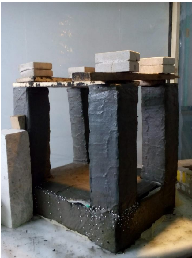
Obr. č. 100 Kotvení kaučukového pláště k jádru a lepení řezů
