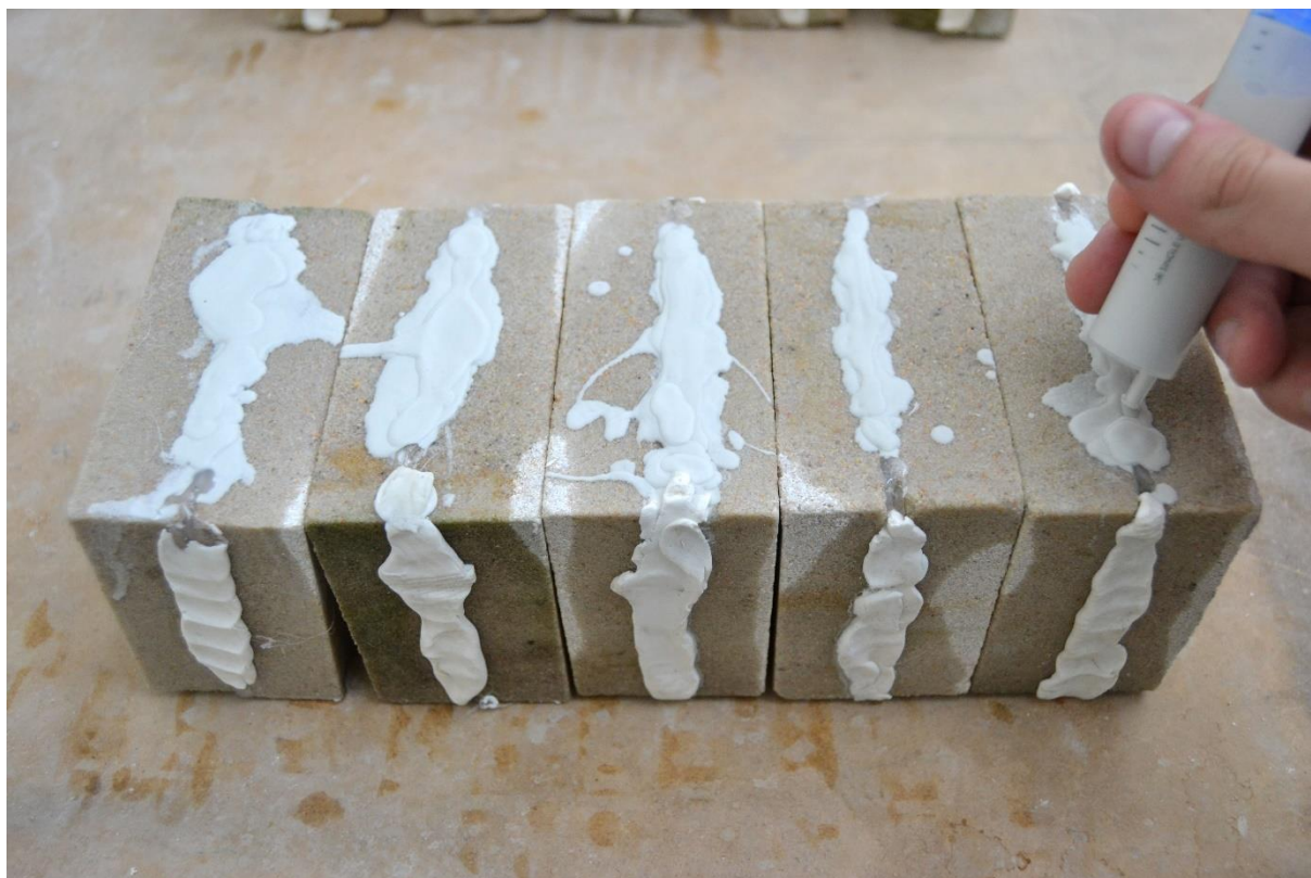
Aplikace injektážního materiálu
