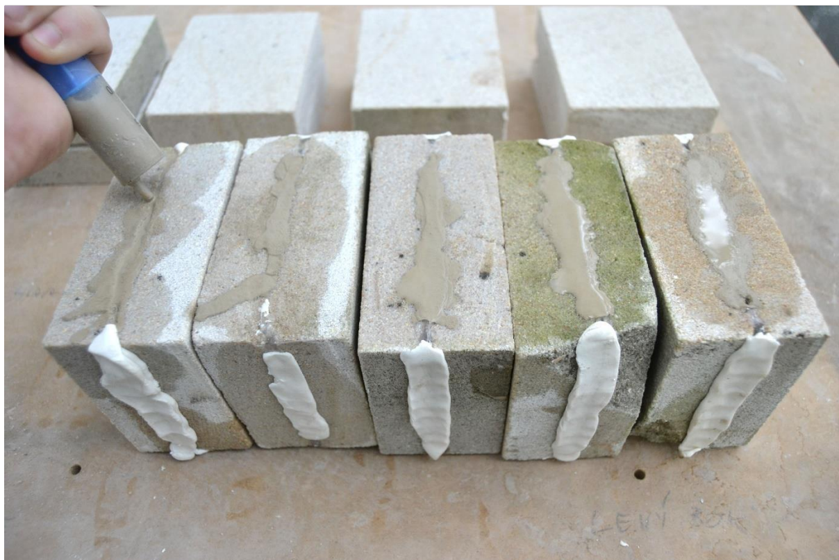
Aplikace injektážního materiálu
