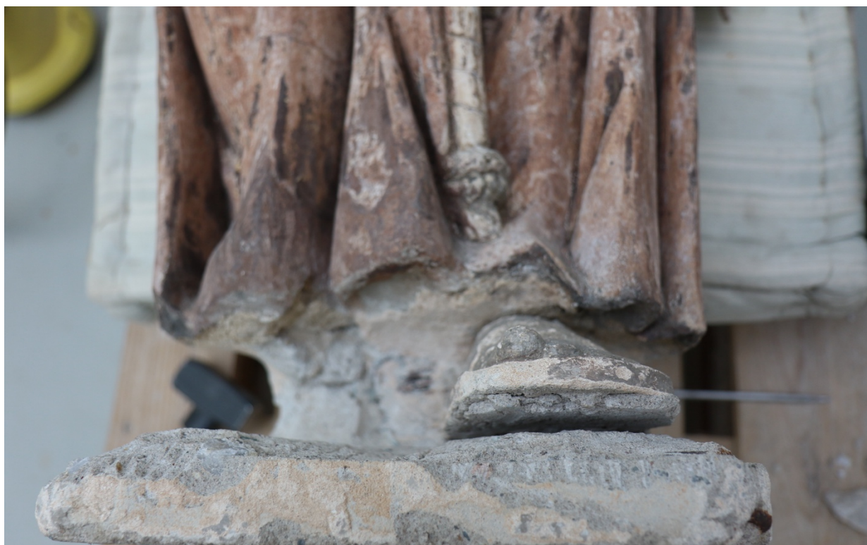
Obr. 69 demontáž doplňku chodidla od soklové části
