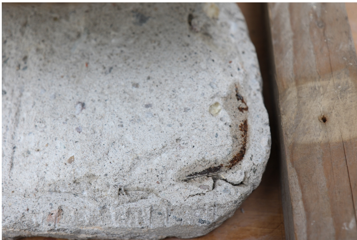
Obr. 77 ošetření vnitřní konstrukce
