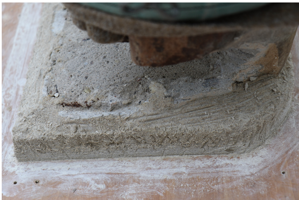
Obr. 84 zhotovení jádra pro novou soklovou část
