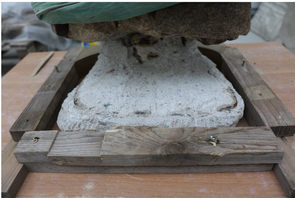
Obr. 75 zhotovení ohrádky pro nový sokl
