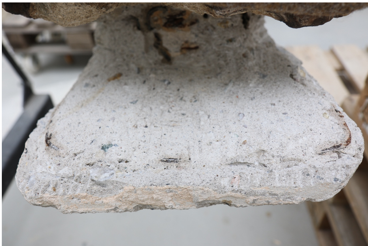
Obr. 79 soklová část s obnaženou, ošetřenou vnitřní konstrukcí
