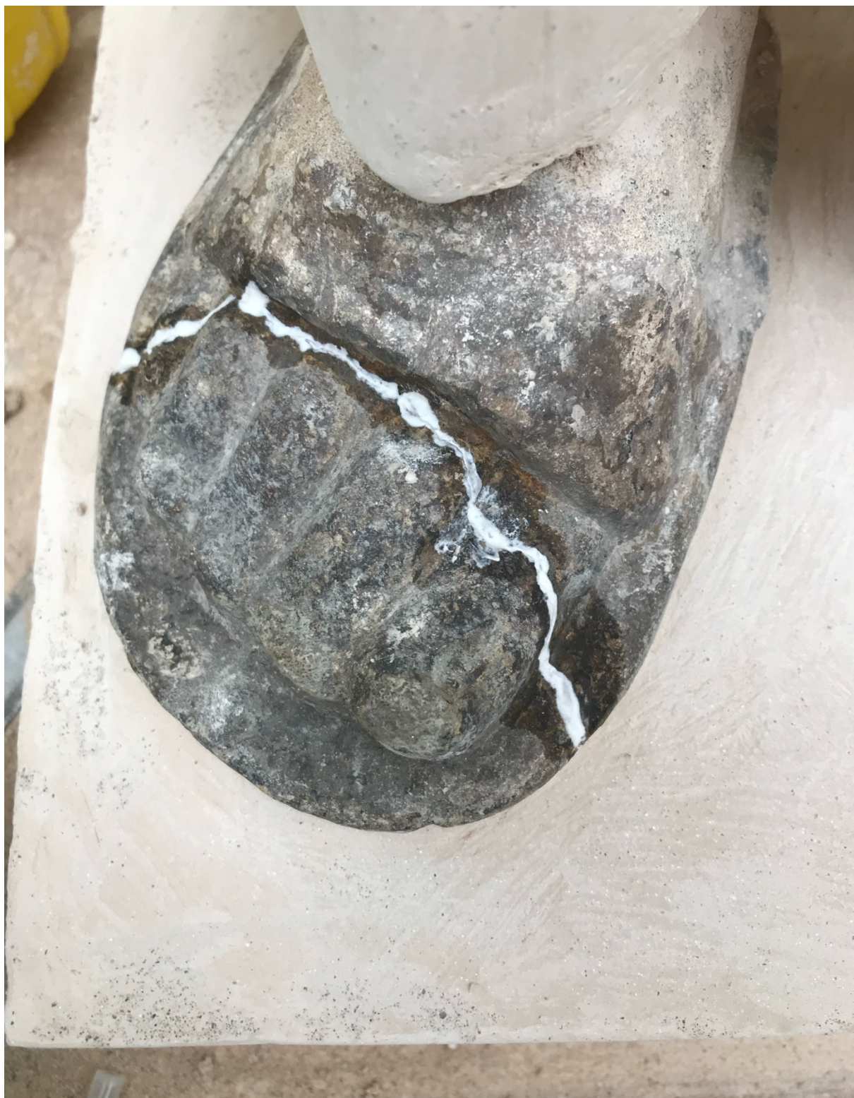
Obr. 91 pravá noha, proinjektovaná prasklina
