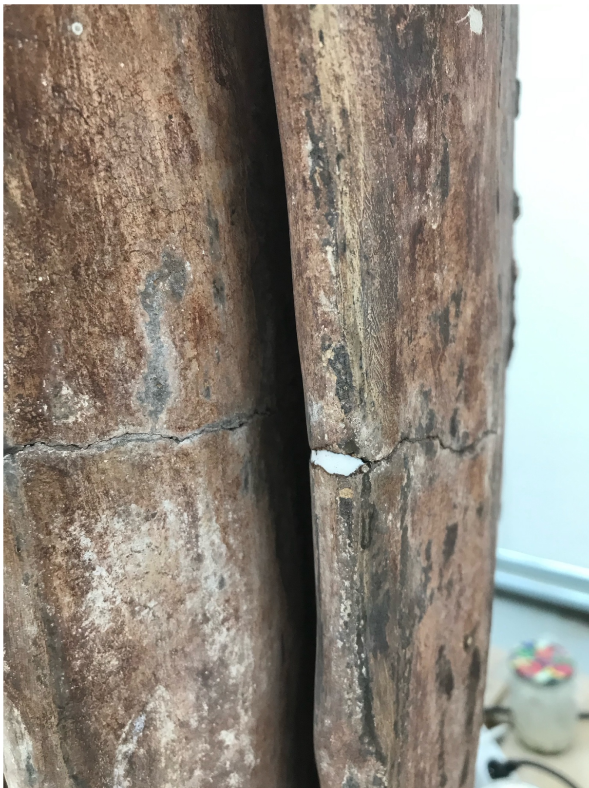
Obr. 92 plášť sv. Antonína, proinjektování praskliny
