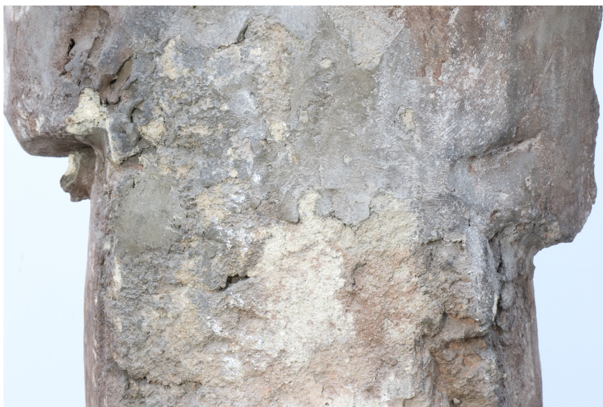
Obr. 53 stav díla před restaurováním, detail zadní strana, stav povrchu
