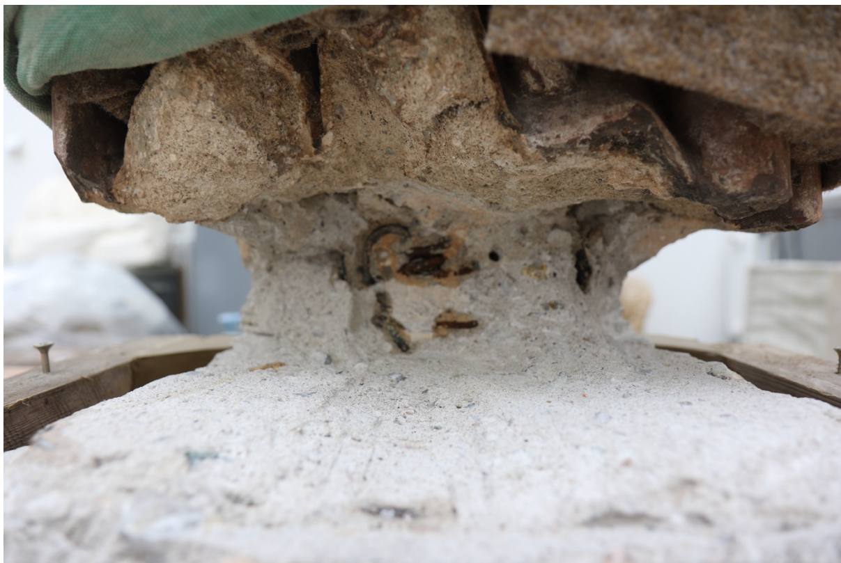
Obr. 76 ošetření vnitřní konstrukce
