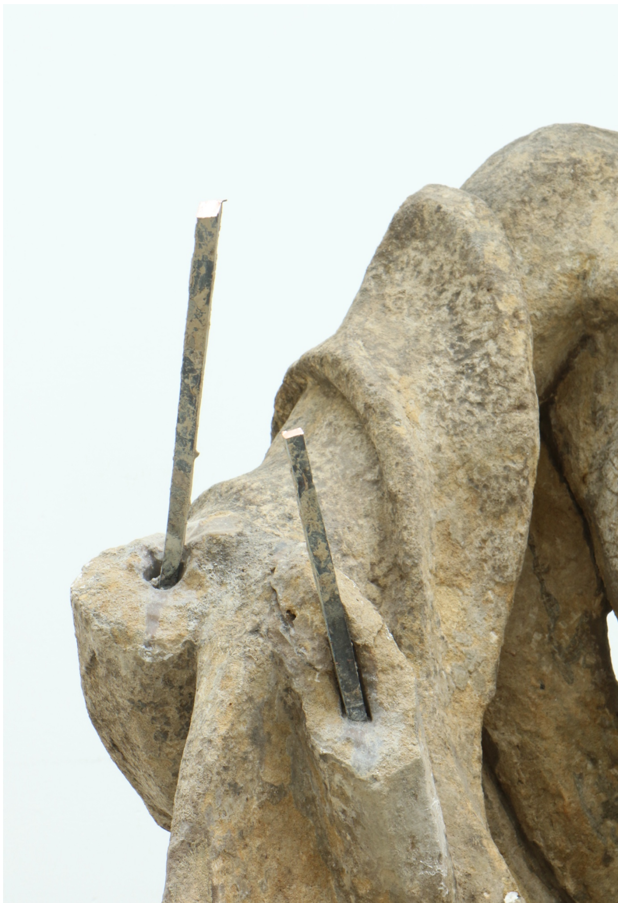
Obr. 116 příprava stávající konstrukce, zkrácení
