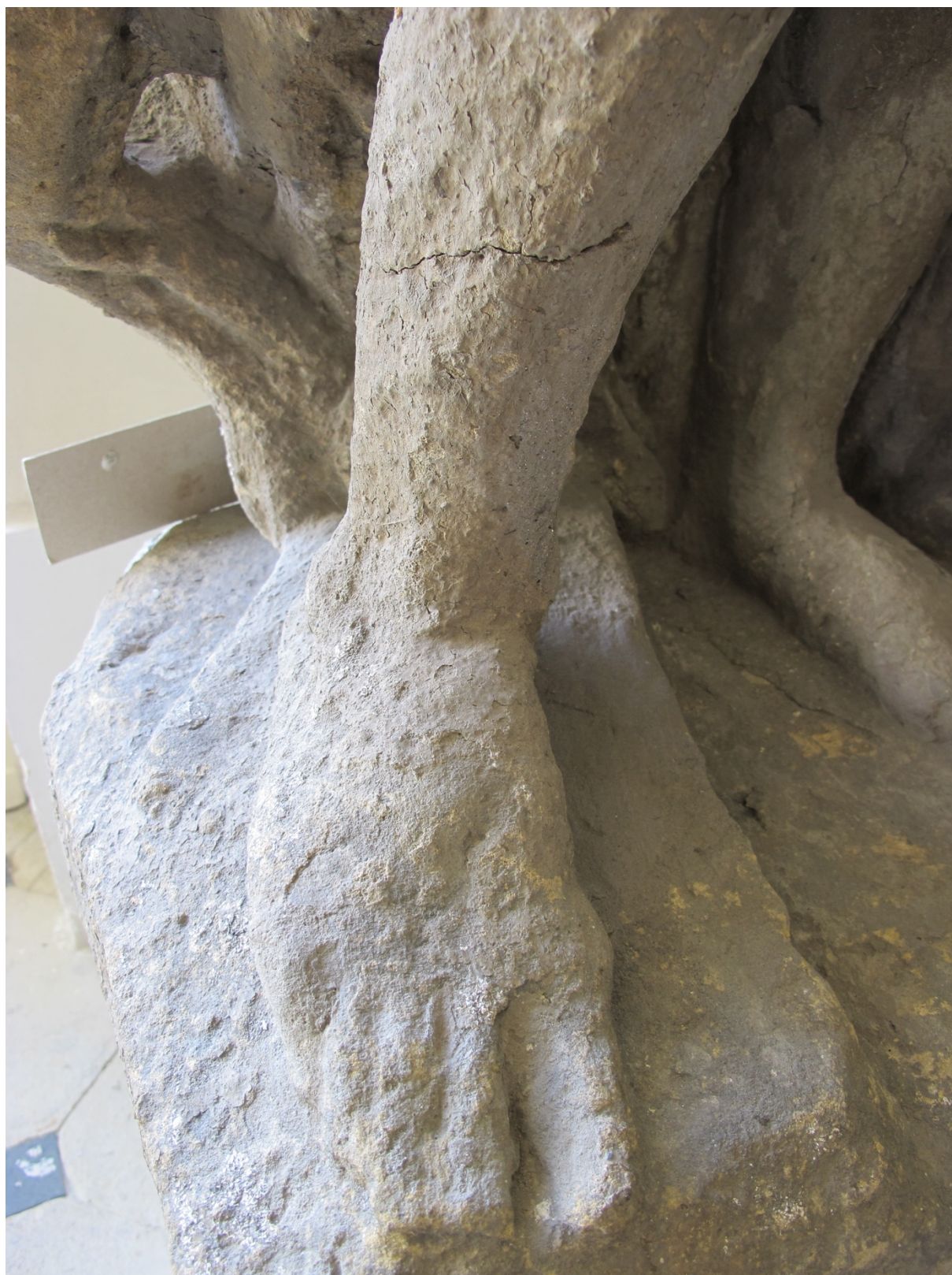
Obr. 31 stav díla před restaurováním, detail pravé nohy
