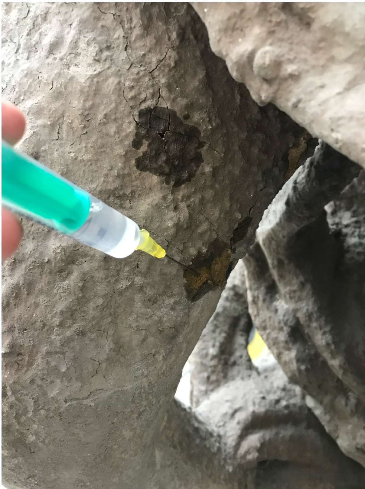
Obr. 55 průběh konsolidace
