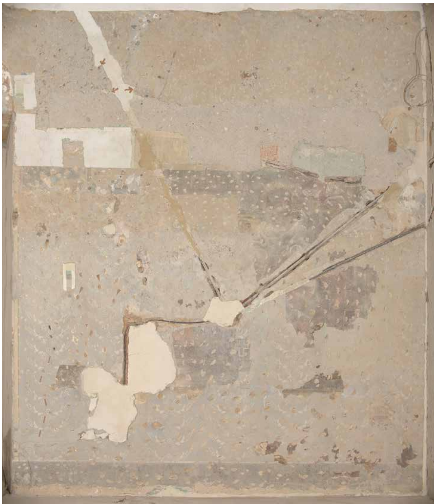
celek ve VIS po částečném odkryvu vrchních omítek a vyjmutí některých tmelů
