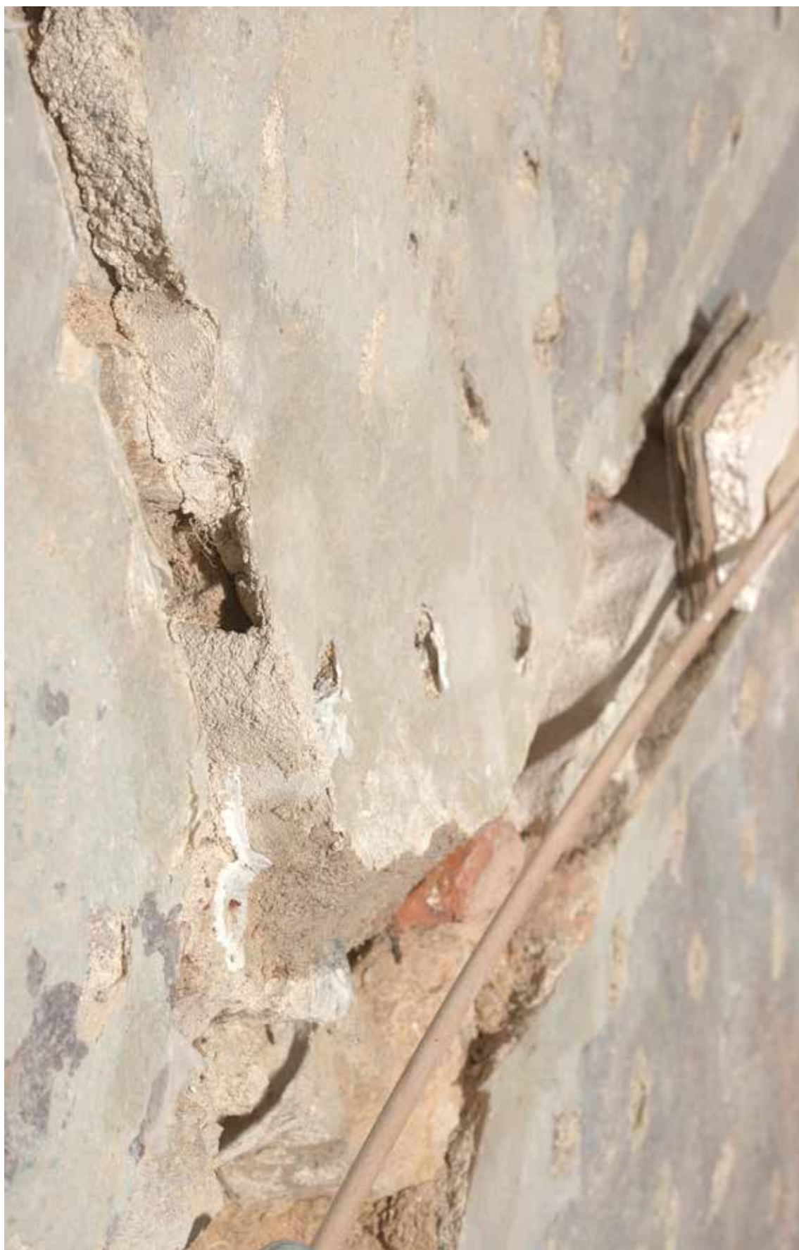
detail ve VIS podtmelení okraje malby
