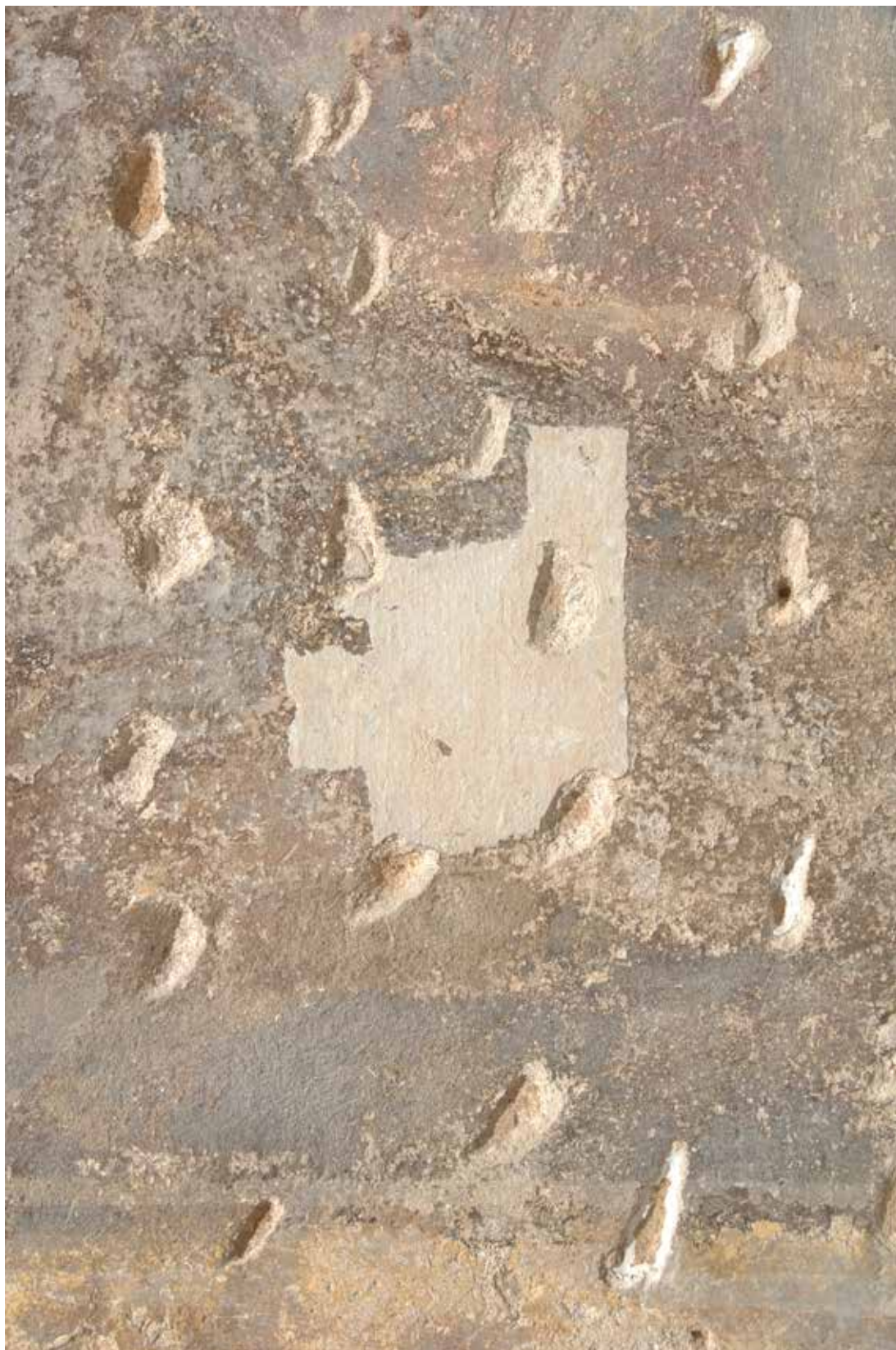
detail ve VIS zbytek šedé vrstvy spodní část s pařezem
