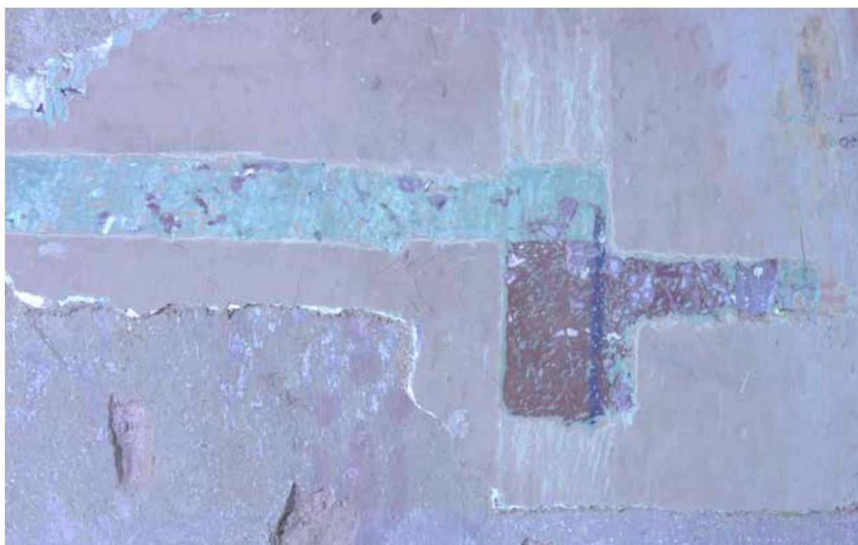
detail ve VIS a UVL sondáž omítkových vrstev
