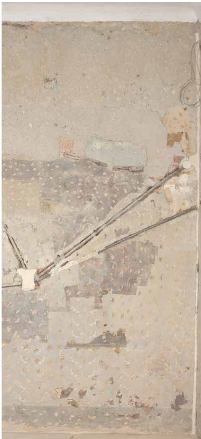
celek ve VIS po částečném odkryvu vrchních omítek a vyjmutí některých tmelů
