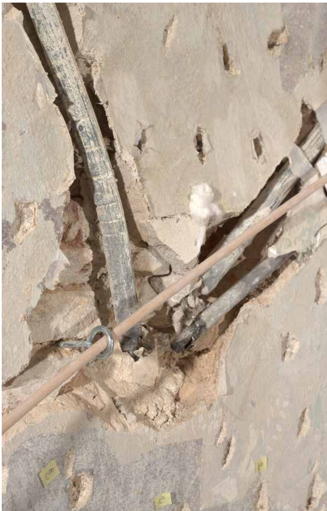
detail ve VIS po odstranění tmelu
