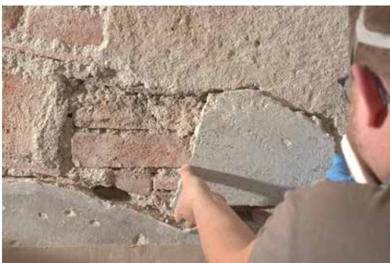
detail ve VIS postupné odstranění betonového tmelu
