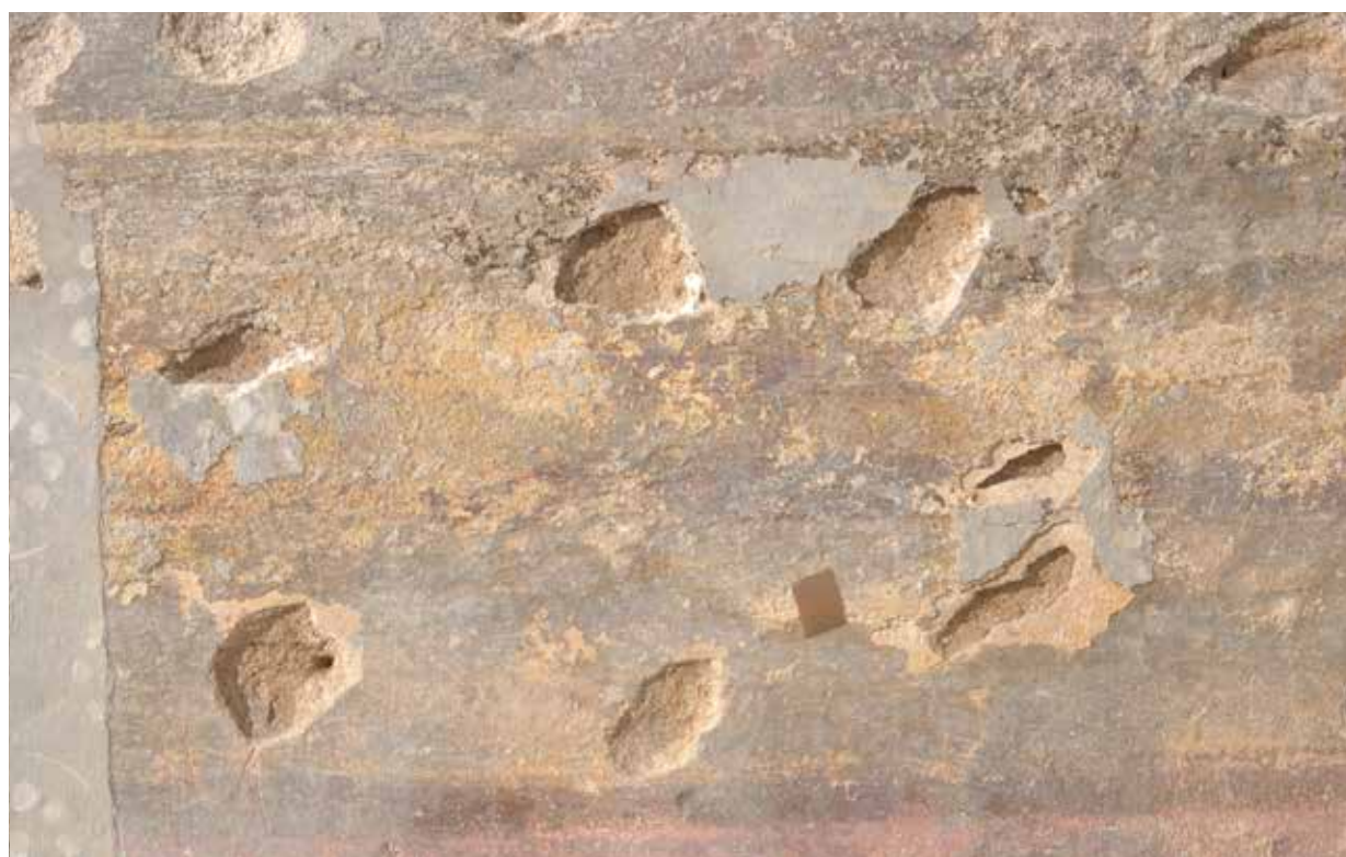
detail ve VIS ledanování injektáží peků spodní část; dekor
