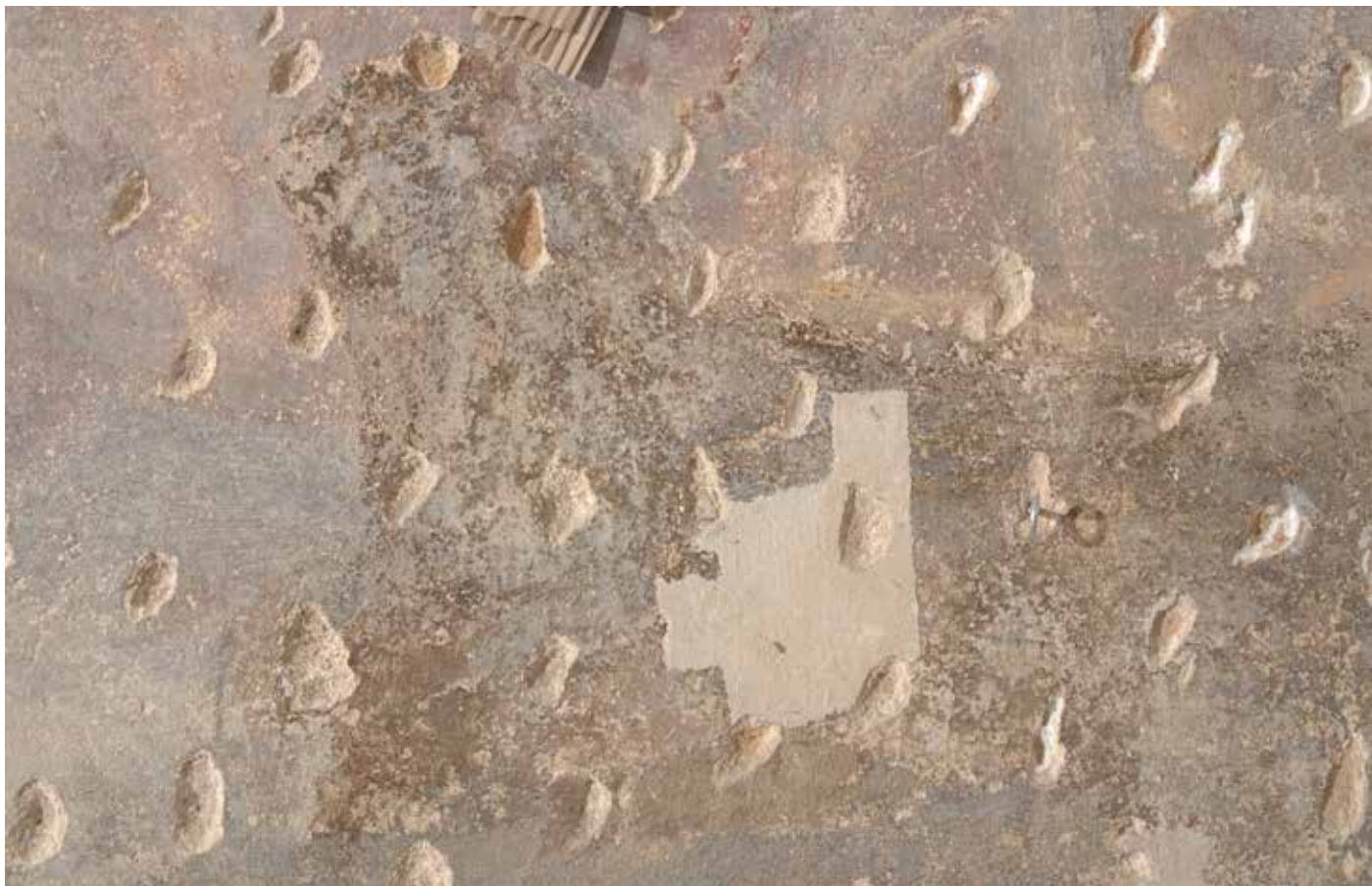
detail ve VIS doodstranění šedého nátěru spodní část - pařez
