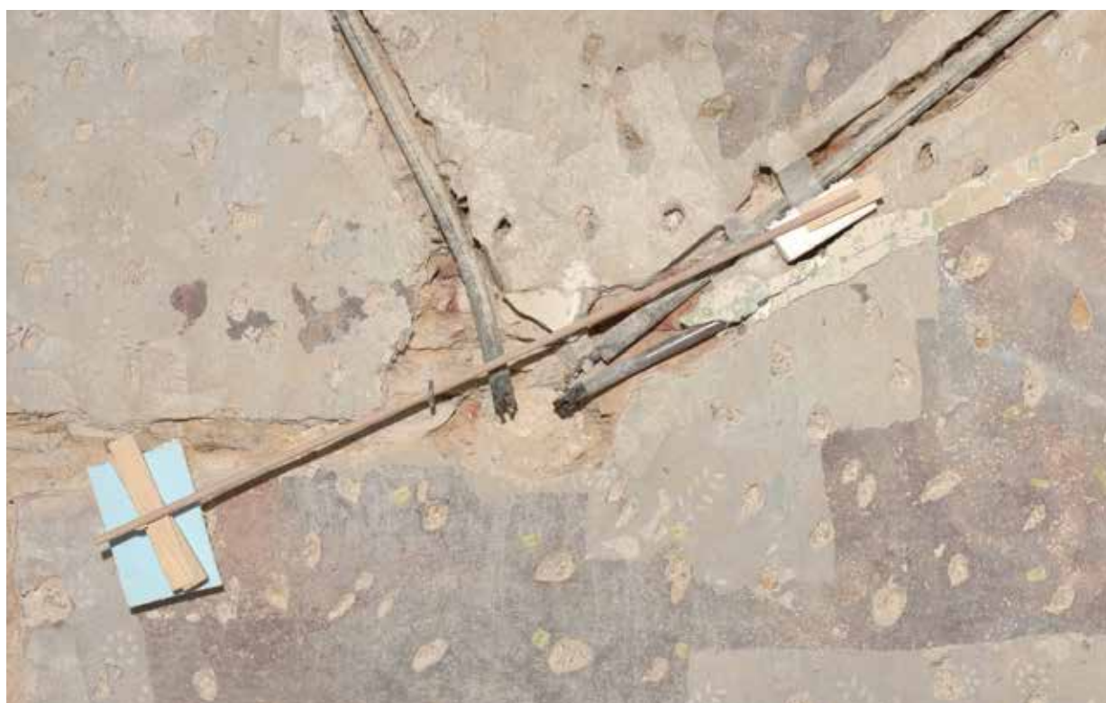
detail ve VIS před a po odstranění betonového tmelu
