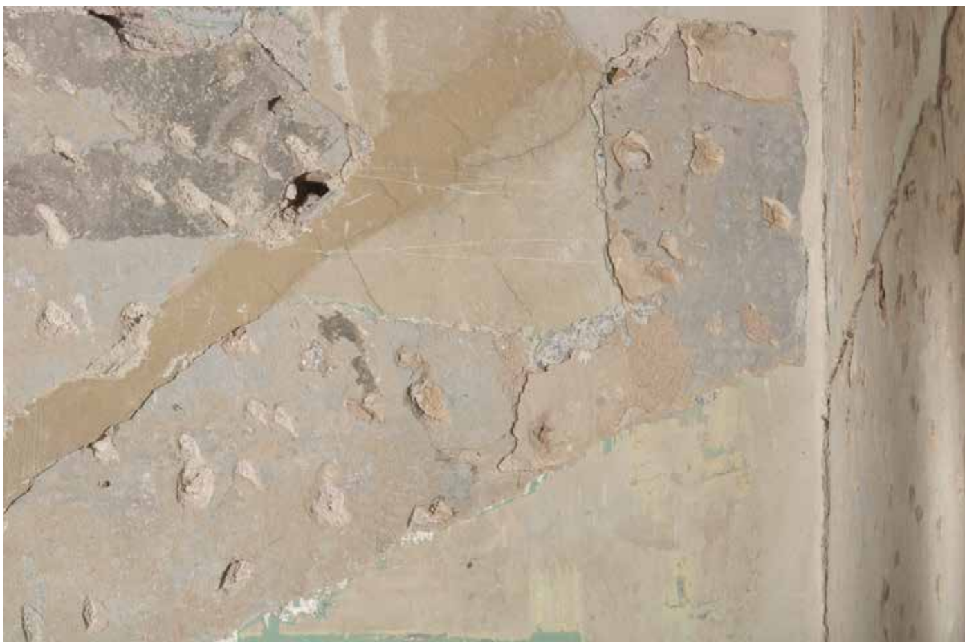
detail ve VIS odkrývání omítky a tmely s elektřinou pravá část
