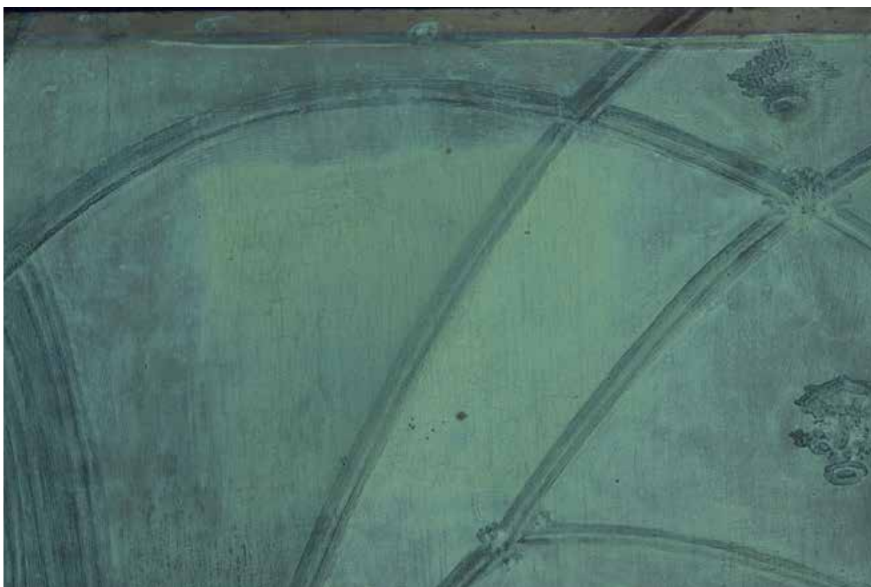
detail ve VIS a UVL ponechaná sonda s nedočištěným lakem horní okraj
