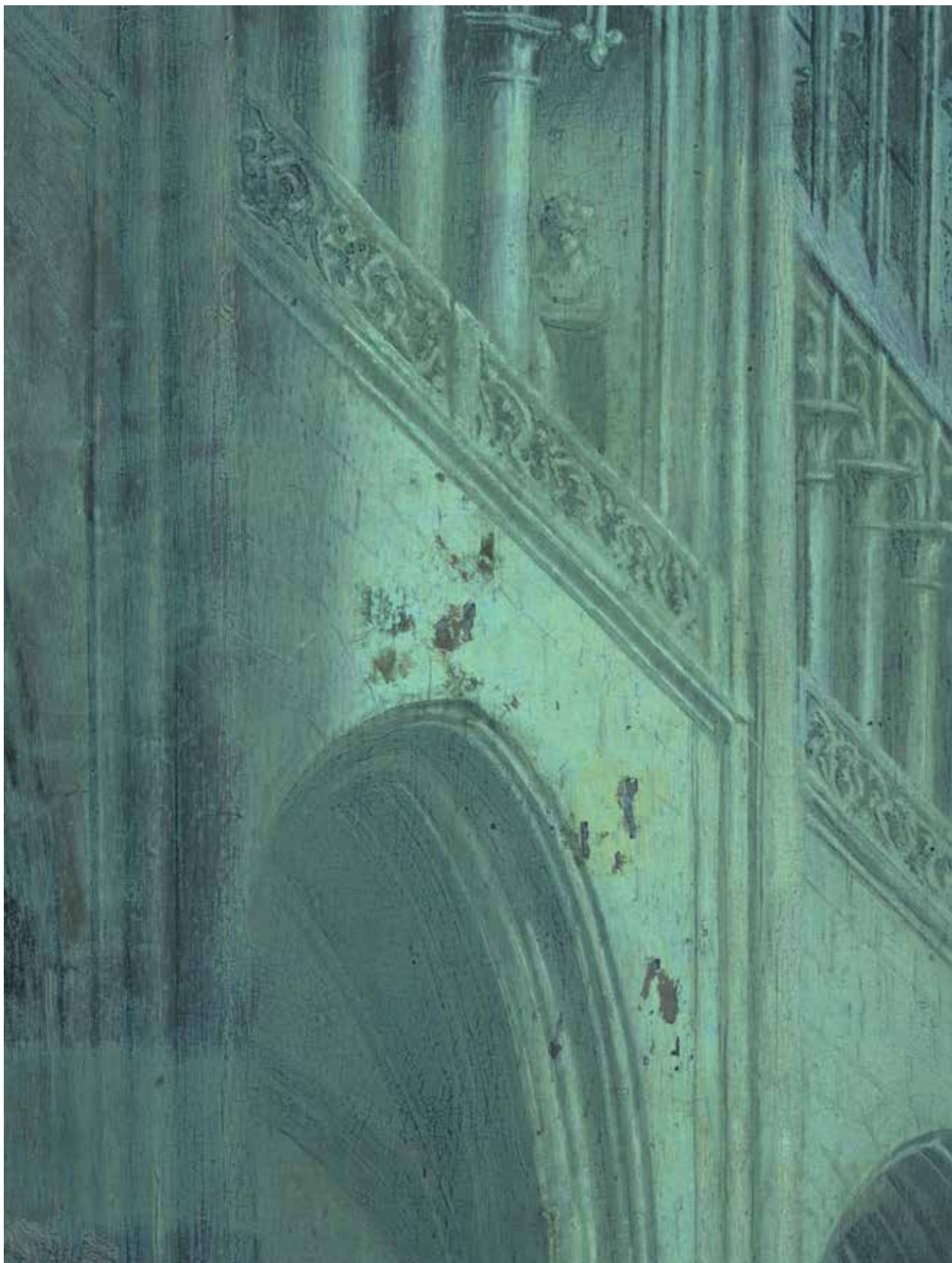
detail UVL ponechaná sonda s nedočištěným zažloutlým lakem levá část
