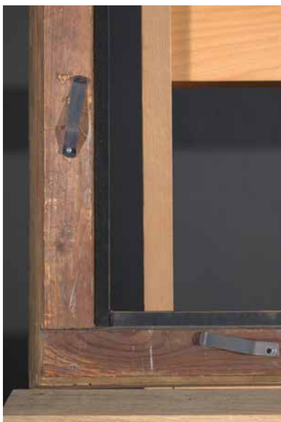
detail VIS zadní úprava vyměkčení lišty a kotvící systém před restaurováním
