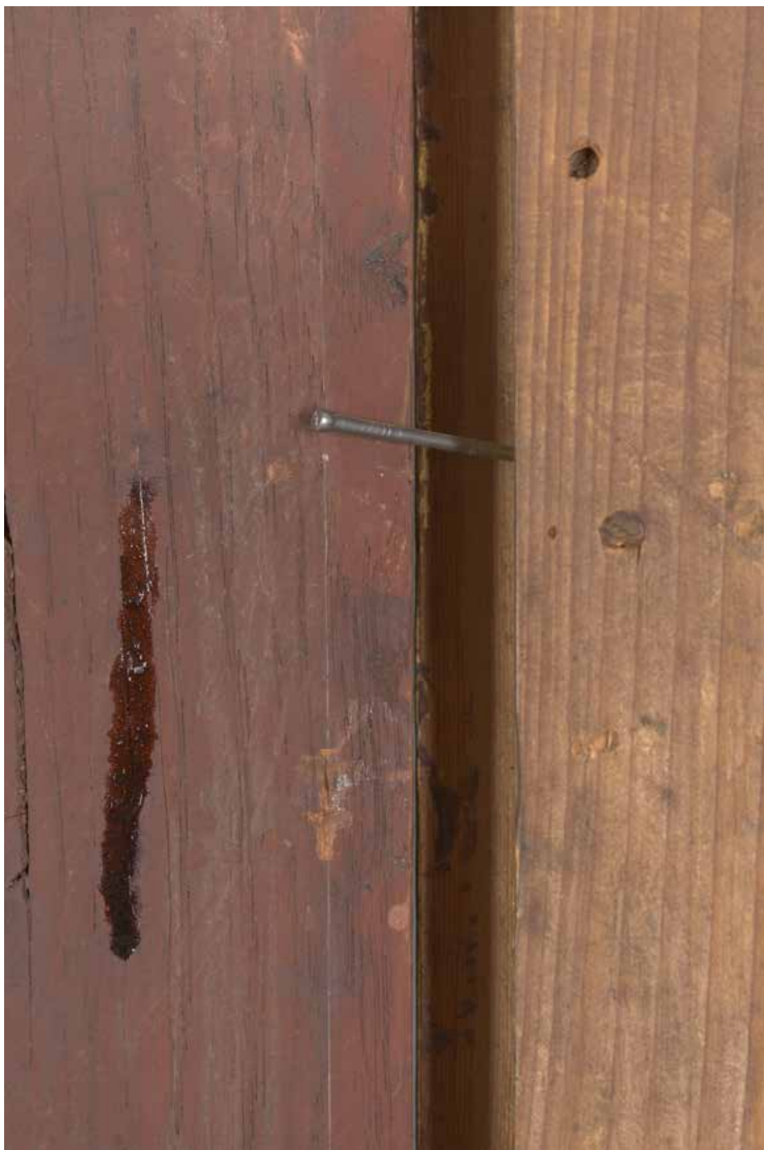
detail ve VIS zadní strana, ukotvení desky k ozdobnému rámu pomocí průmyslových hřebíků
