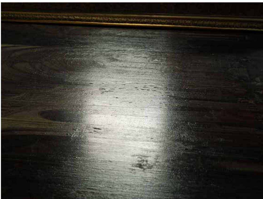
detail ve VISR přední strana, odlesk lakové vrstvy a pozvedaná krakeláž
