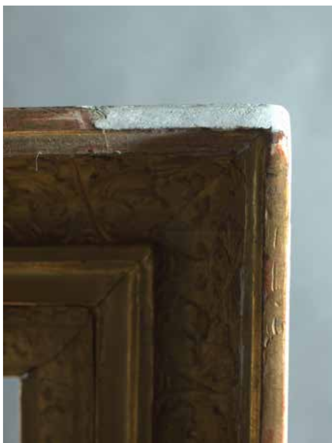
detail VIS a VISR po tmelení defektů
