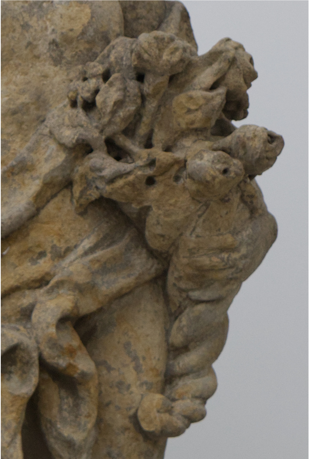
Obr. 75 detail rohu hojnosti s květy po odstranění cementových nátěrů a nevyhovujících tmelů
