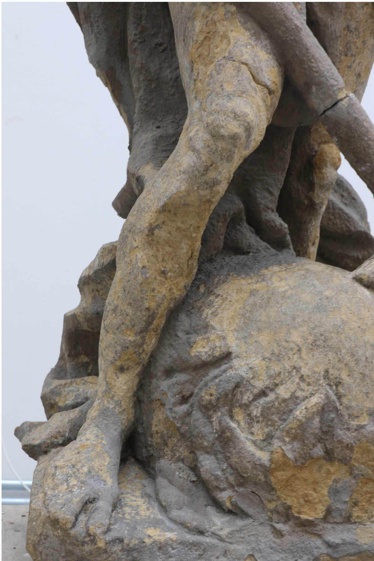
Obr. 48 odstranění nevyhovujících tmelů v pravé noze figury
