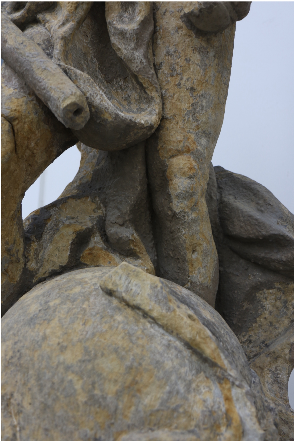
Obr. 65 demontáž poškozeného fragmentu rýče
