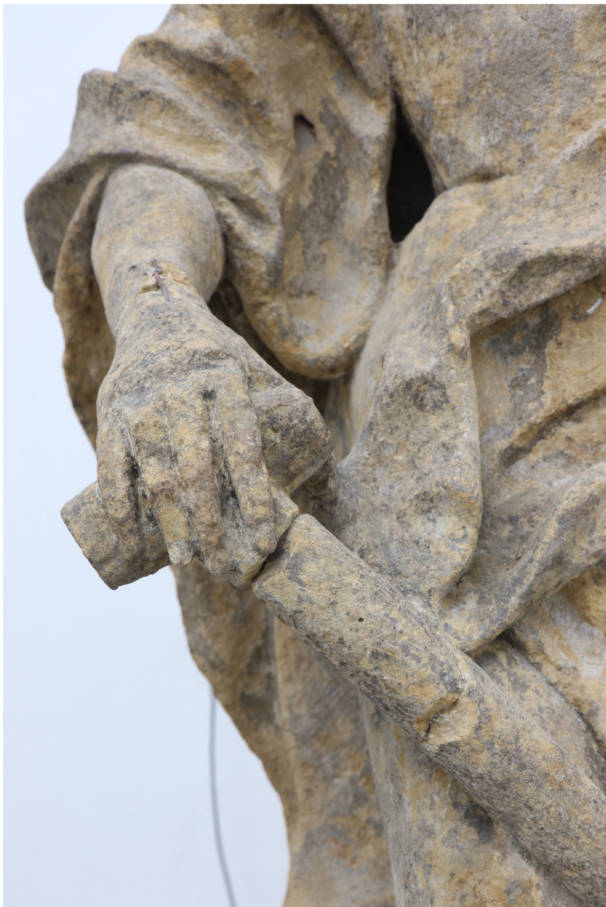
Obr. 62 odhalení konstrukce z předchozího restaurátorského zásahu v předloktí pravé ruky figury a v rukojeti rýče – odstranění tmelů ze spáry
