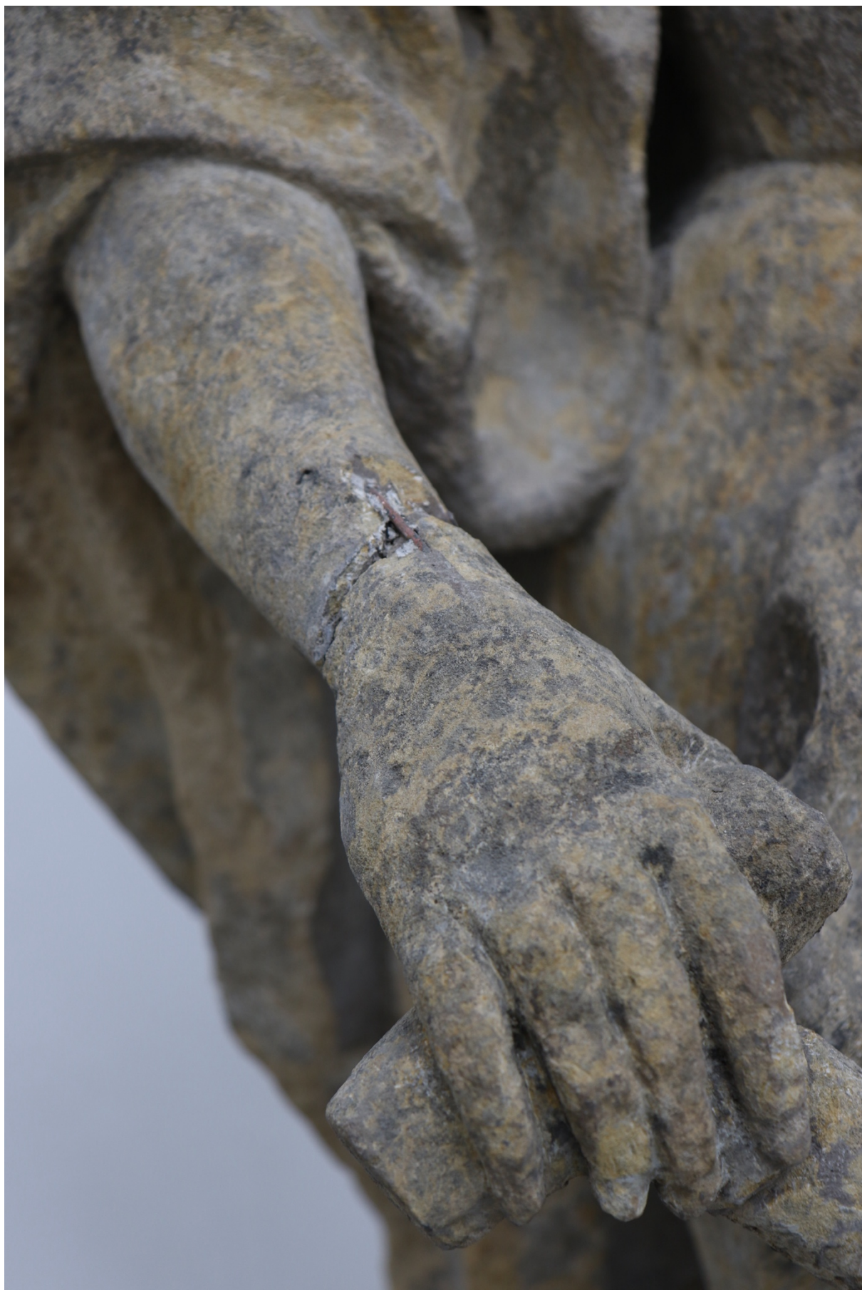
Obr. 57 odhalení konstrukce z předchozího restaurátorského zásahu v předloktí pravé ruky figury
