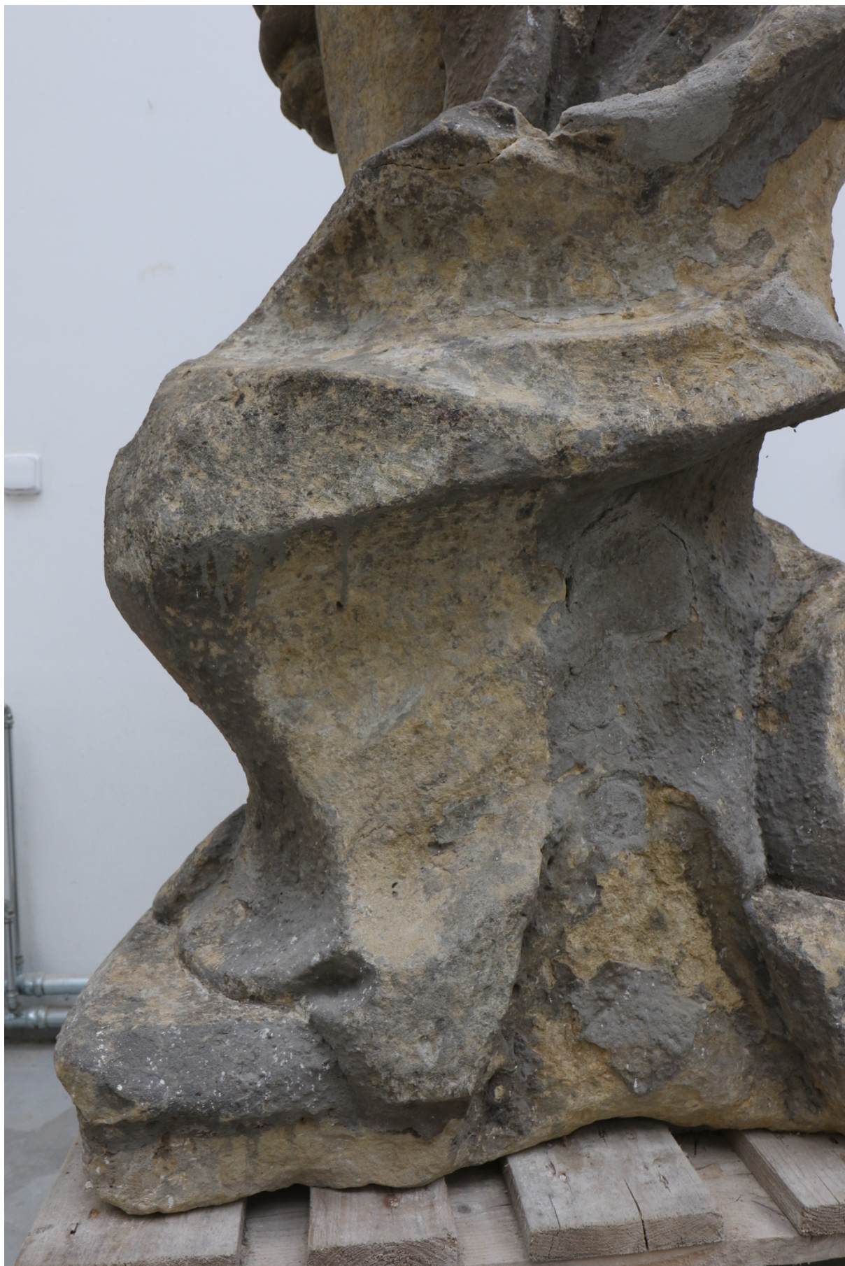
Obr. 78 silná degradace kamenného materiálu v zadní straně díla
