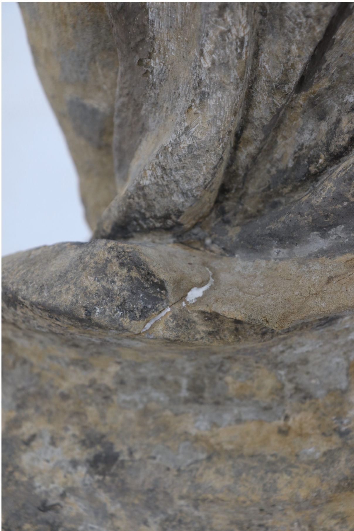
Obr. 56 injektáž – vyplnění trhliny elastifikovaným konsolidantem Remmers
