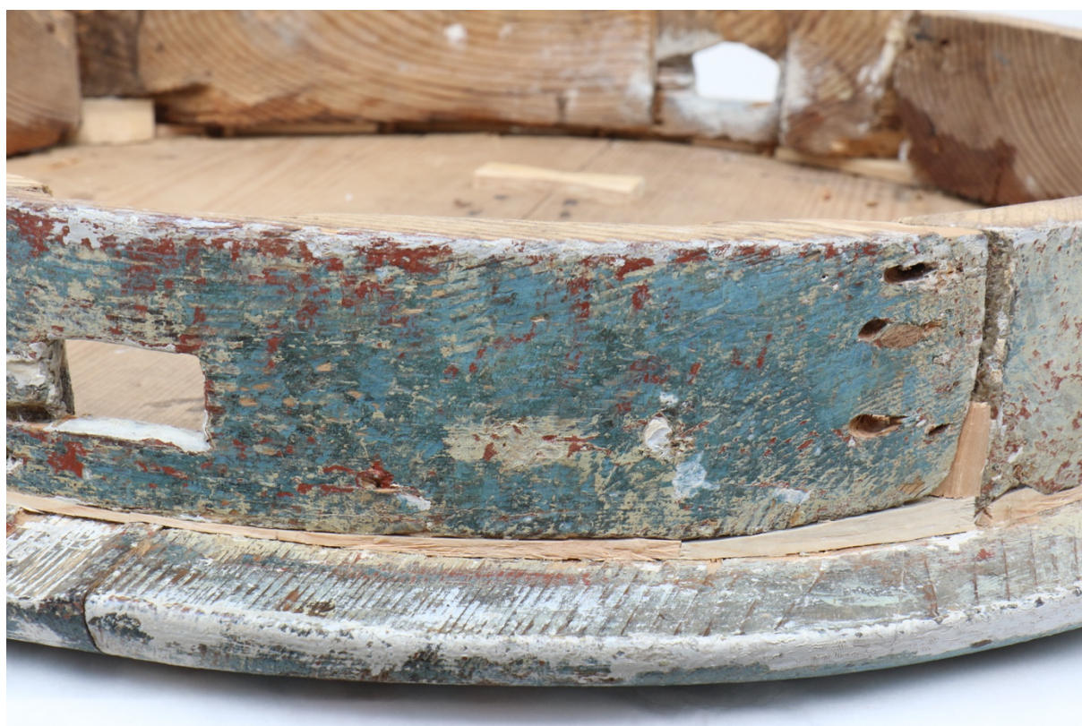
Obr. 105 špánování vzniklých spár
