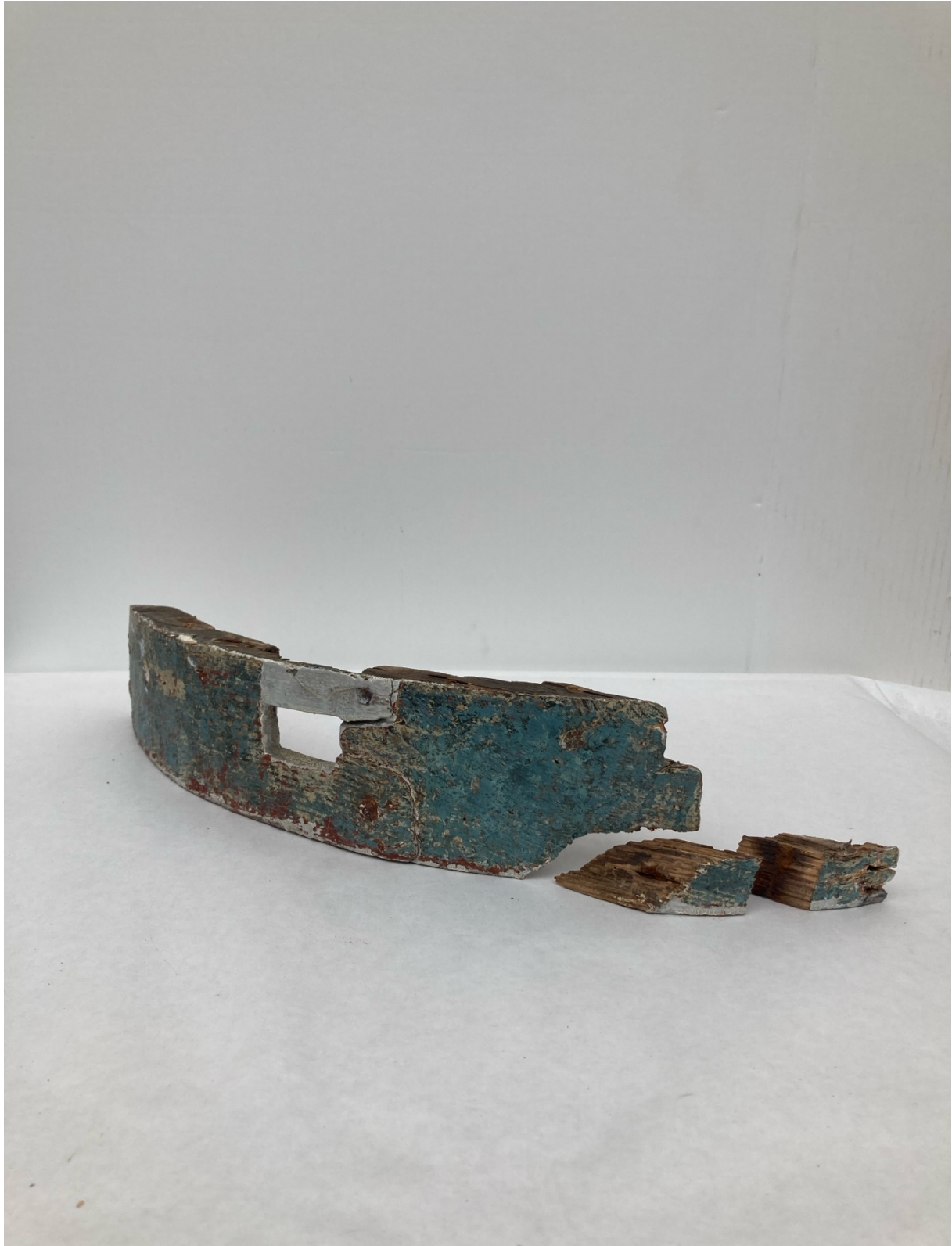
Obr. 88 detail poškození obruby
