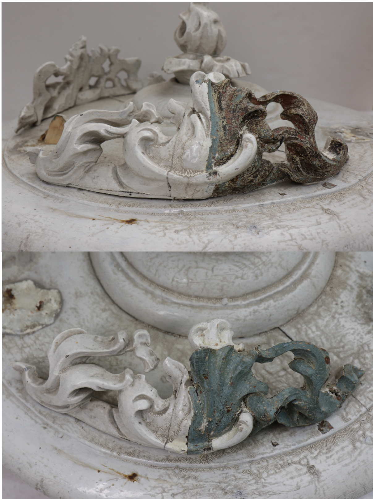
Obr. 53 průběh snímání nepůvodních vrstev
