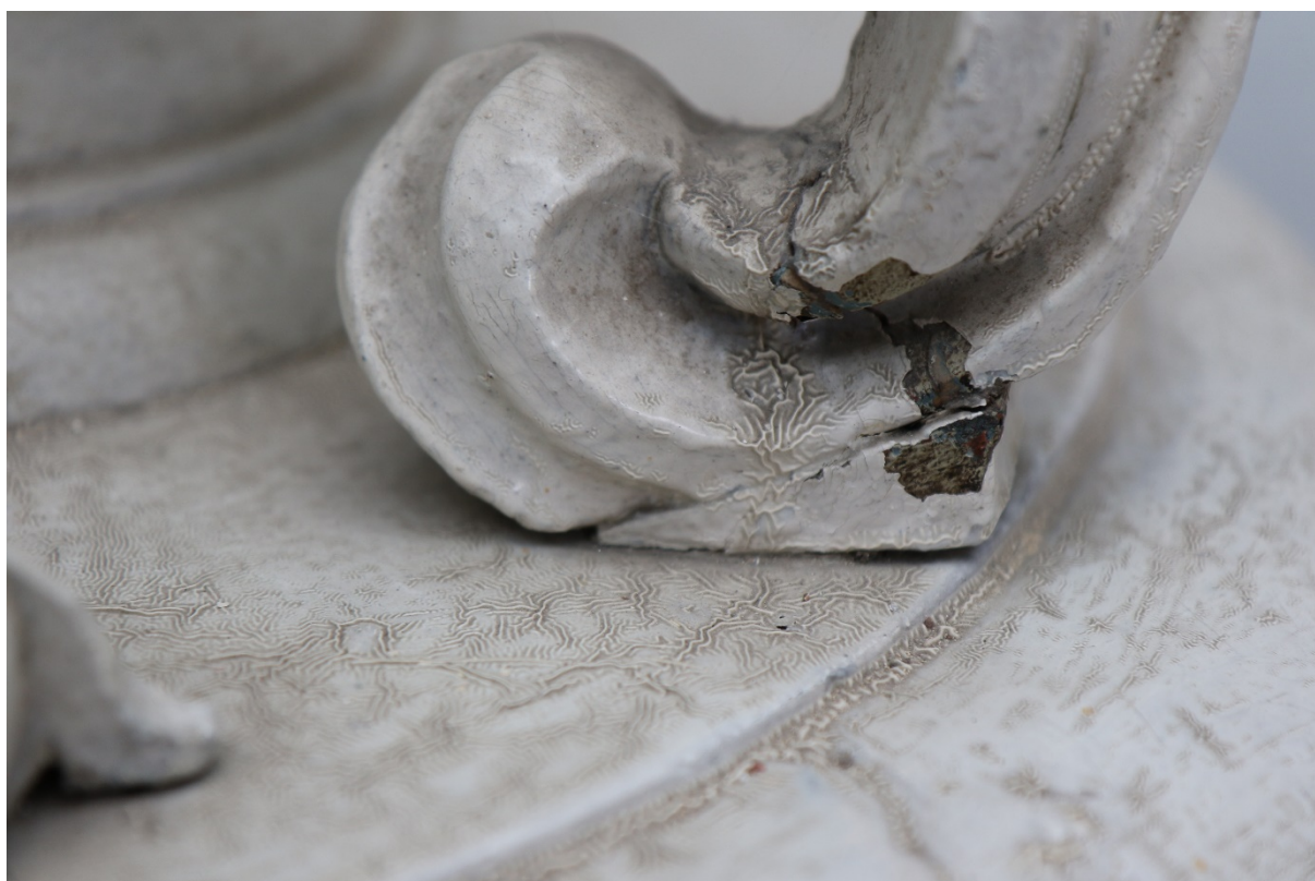
Obr. 18 stav díla před restaurováním – detail poškození
