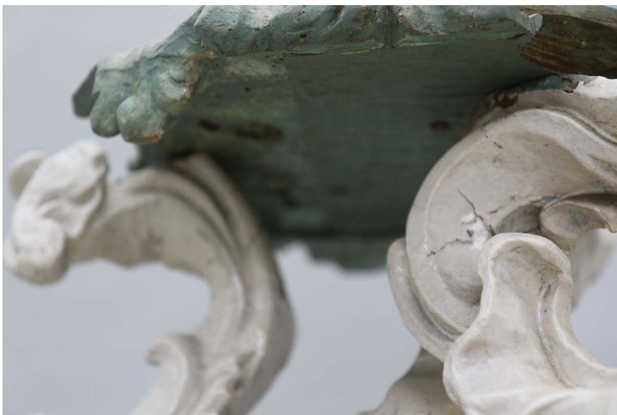
Obr. 16 stav díla před restaurováním – detail poškození polychromie
