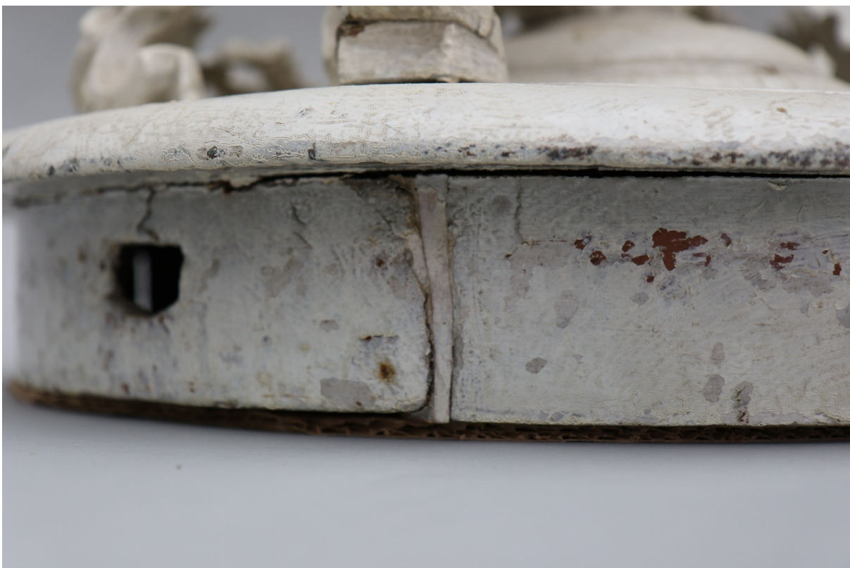
Obr. 24 stav díla před restaurováním – detail poškození
