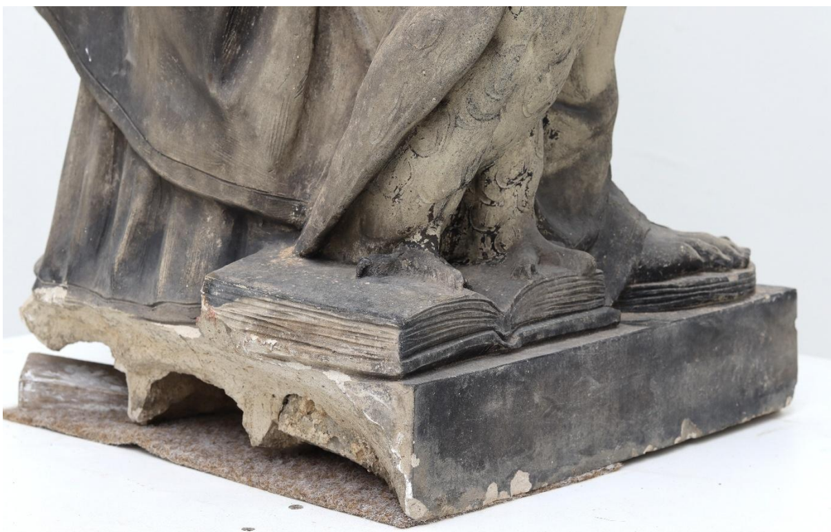
Obrázek 17 Stav díla před restaurováním, detailní fotografie na defekty v oblasti soklu. Lze zde vidět cementovou výplň v obnažené soklové části.
