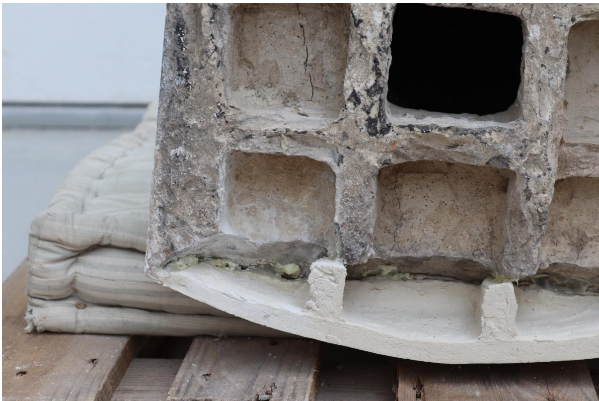
Obrázek 71 Stav stojné plochy po přisazení zadní části keramického doplňku. Před očištěním a napojení žeber originálu a doplňku
