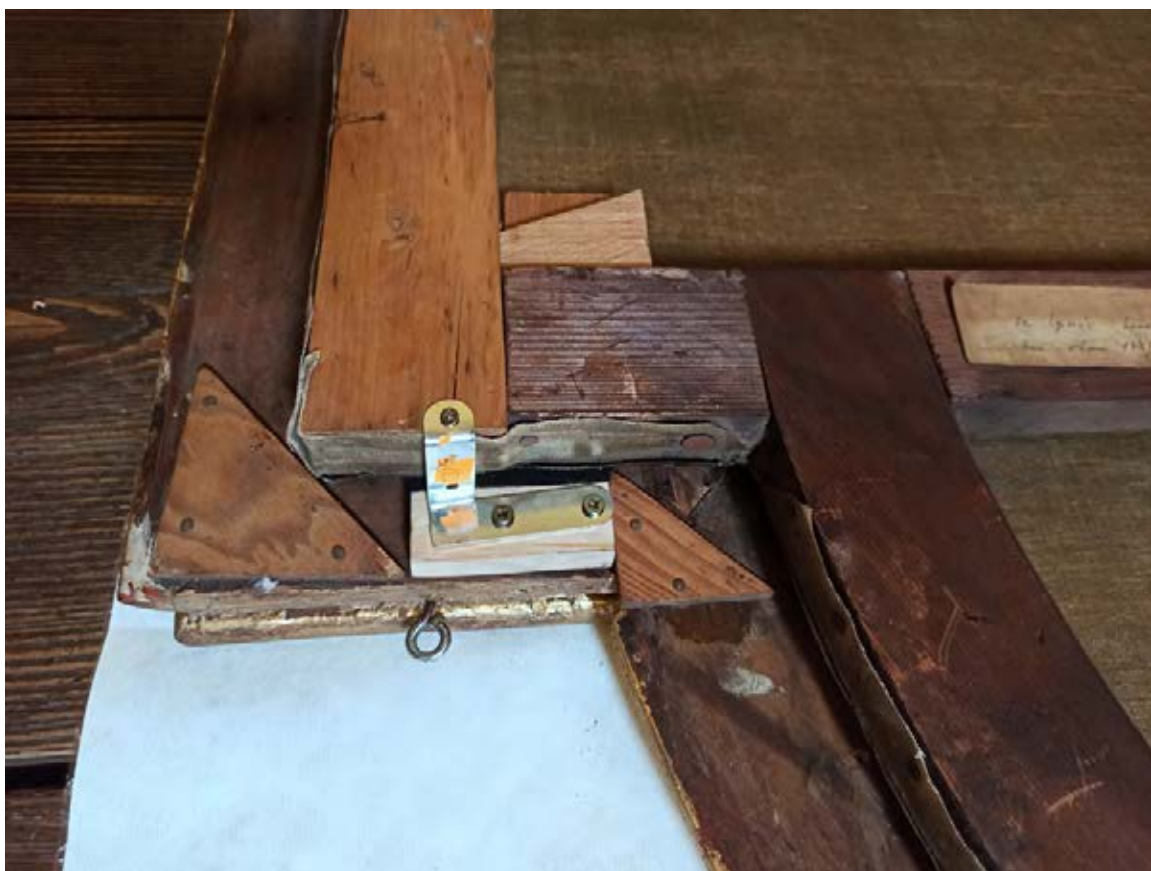
Dřevěná nástavba ve vnitřní části ozdobného rámu s kovovým kotvícím prvkem
