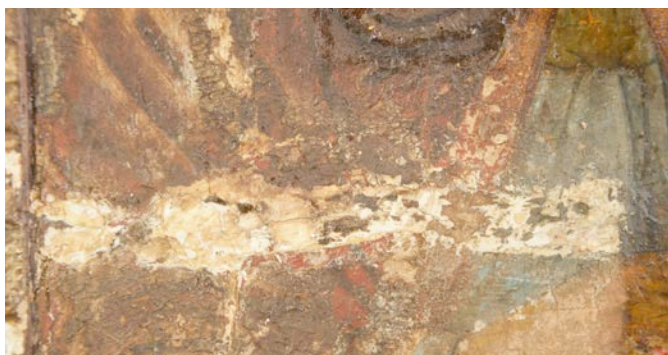
• Obr. 121 - Detail Poškození malby v průběhu restaurování.
