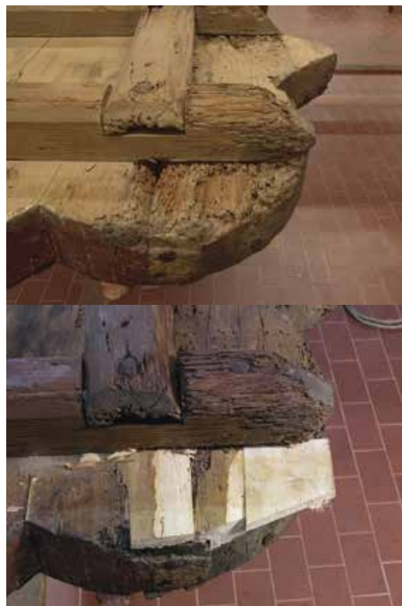
Po petrifikaci, byla chybějící místa desky doplněna špalíky starého dřeva(jedle).
