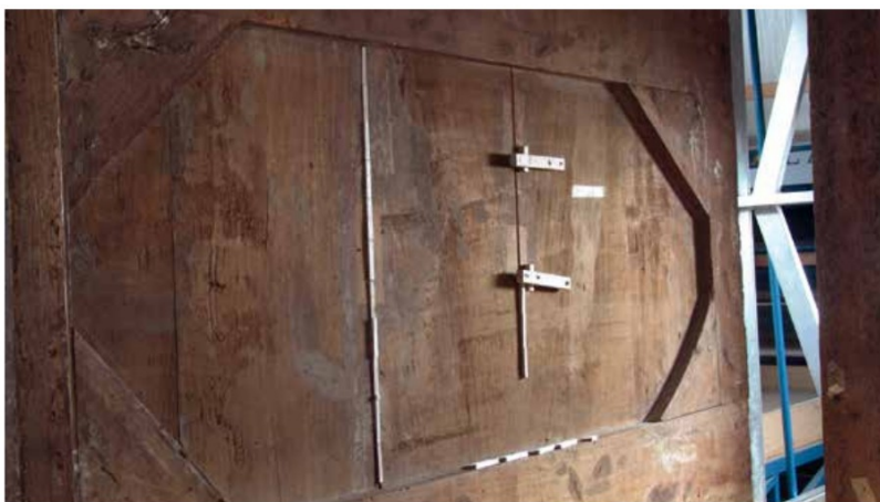
Detail části spoje doplněné balzovými klínky.
