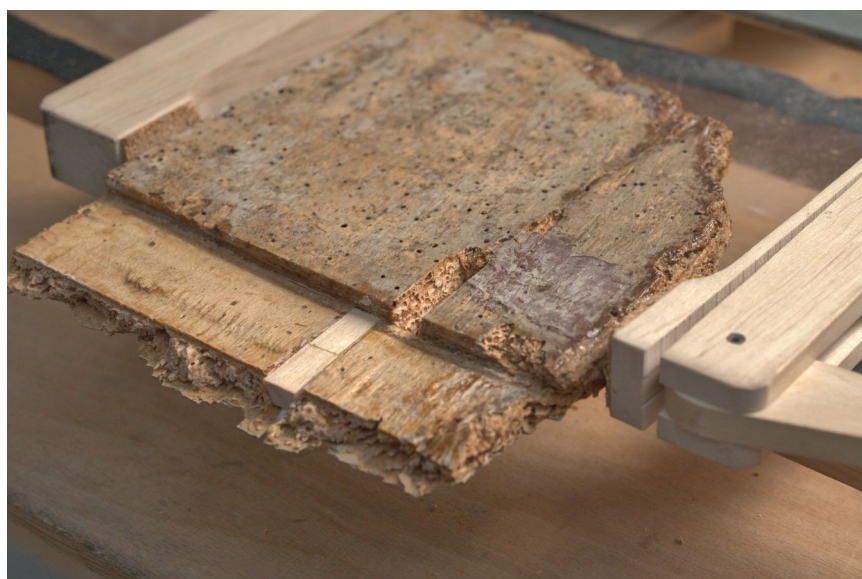
Vytvořený zážlab sleduje směr praskliny
