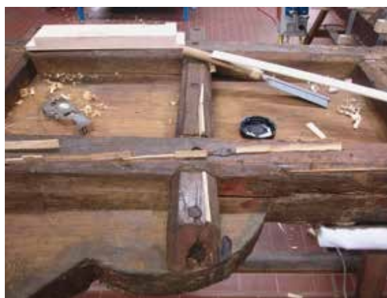
Trhliny na svlacích byly vyfrézovány a do drážky vlepeny trojúhelníkové špalíky z jedlového dřeva. Lepidlem byla směs epoxidů Araldite AW 106/HV 953U (1:0.8) a Araldite SV 427/HV 427 (1:1) v poměru 1:1.
