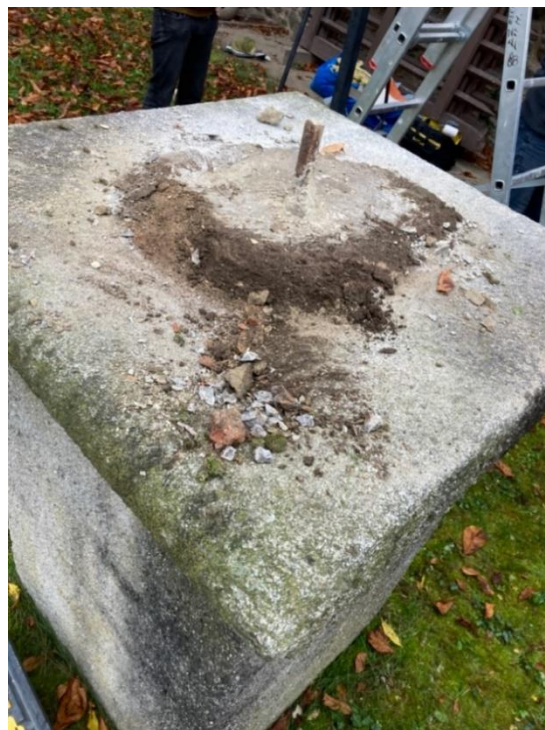
Obrázek č. 25: Armatura 2
