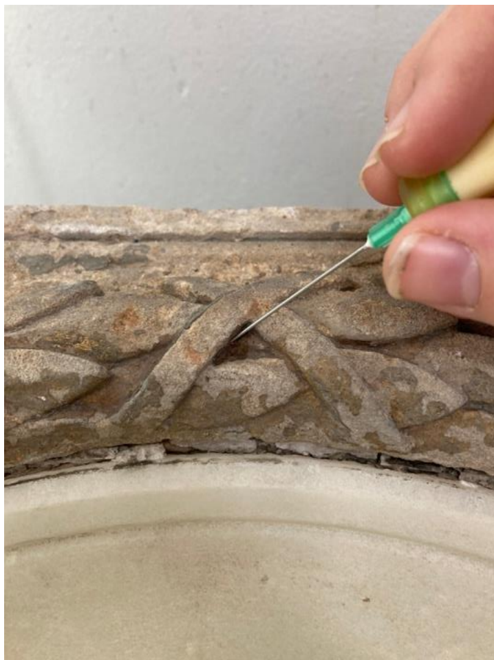
Obrázek č. 5: Předzpevnění nestabilní části před čištěním
