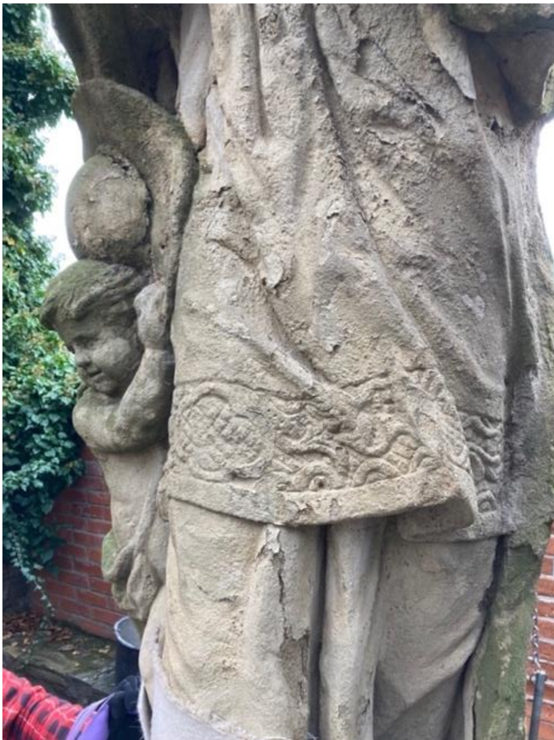
Obrázek č. 9: Ukázka špatného zpracování výspravků a přetěrů
