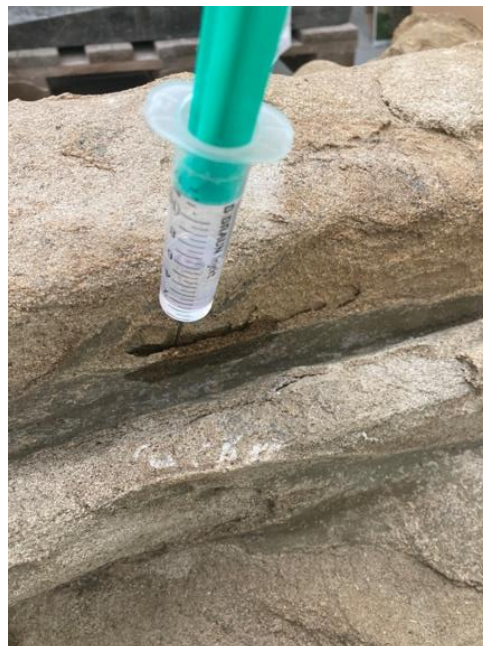
Obrázek č. 19: Použití zpevňovače na bázi esterů kyseliny křemičité
