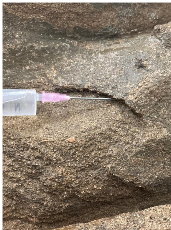
Obrázek č. 21: Trhliny na pískovci
