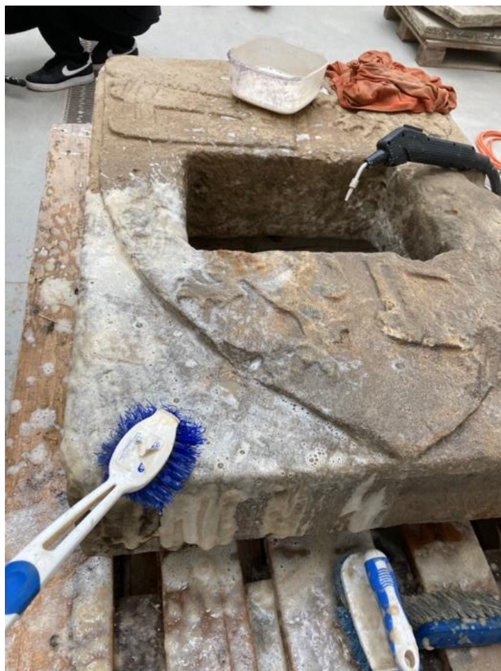
Obrázek č. 6: Použití chemického přípravku a následné mechanické očištění
