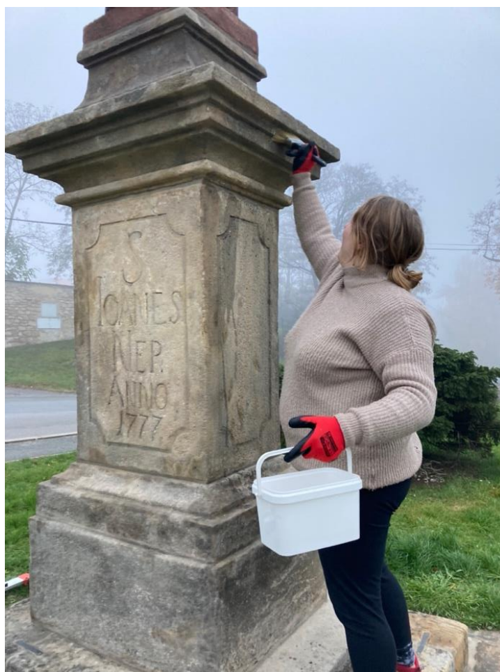
Obrázek č. 27: Ošetření hydrofobním přípravkem
