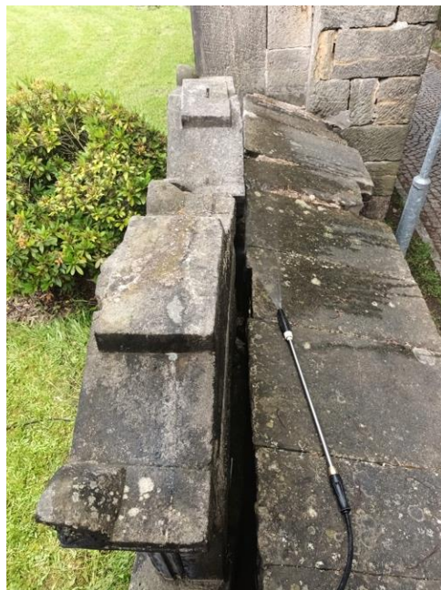
Obrázek č. 17: Ukázka čištění tlakovou vodou
