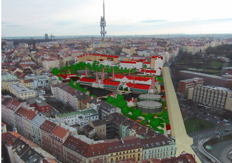
Pražská obecní plynárna na Žižkově kolem roku 1924. Záznam do současného stavu.
