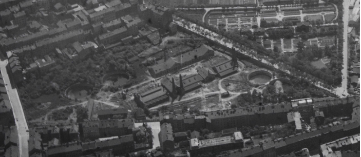
První žižkovská obecní plynárna na leteckém snímku z roku 1931.
