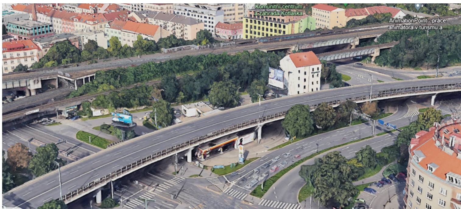
Obr. 1: nadhledový snímek řešené lokality
