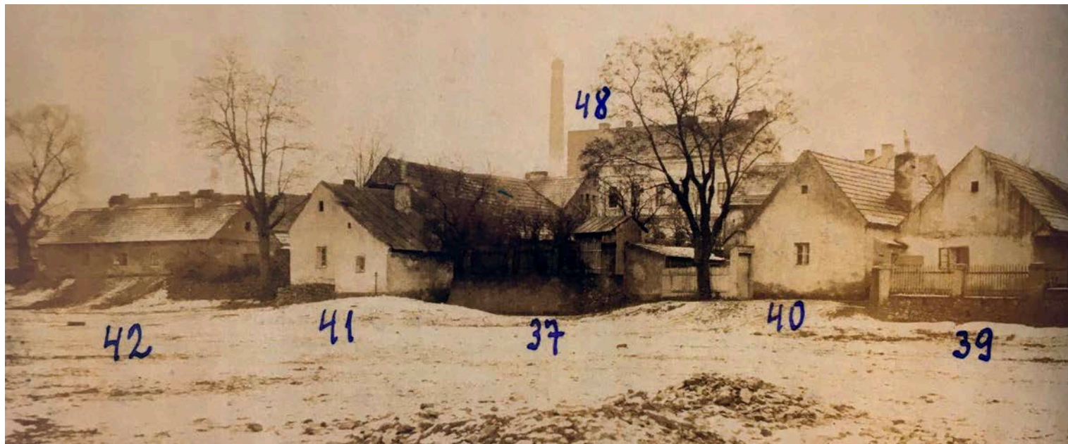
Obr. 7 - Domy na východní části Holešovického nábřeží, částečně zbourané při stavbě Trojského mostu (před 1. sv. válkou)
