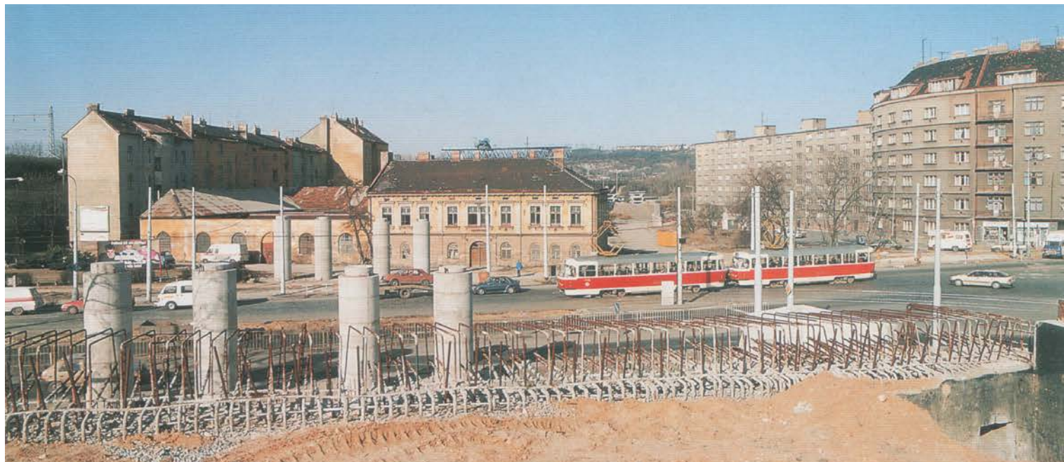
Obr. 4: výstavba viaduktu Městského okruhu (MO) r. 1994
