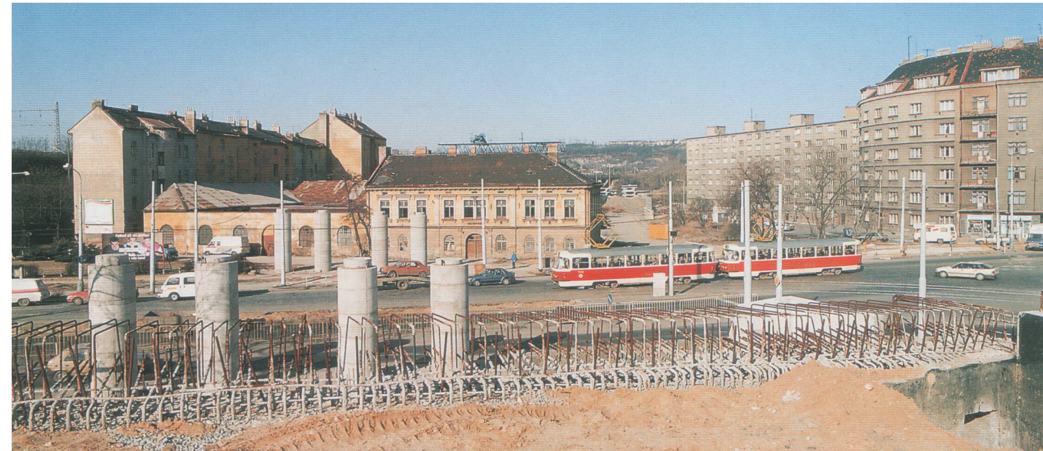
Obr. 4: výstavba viaduktu Městského okruhu (MO) r. 1994
