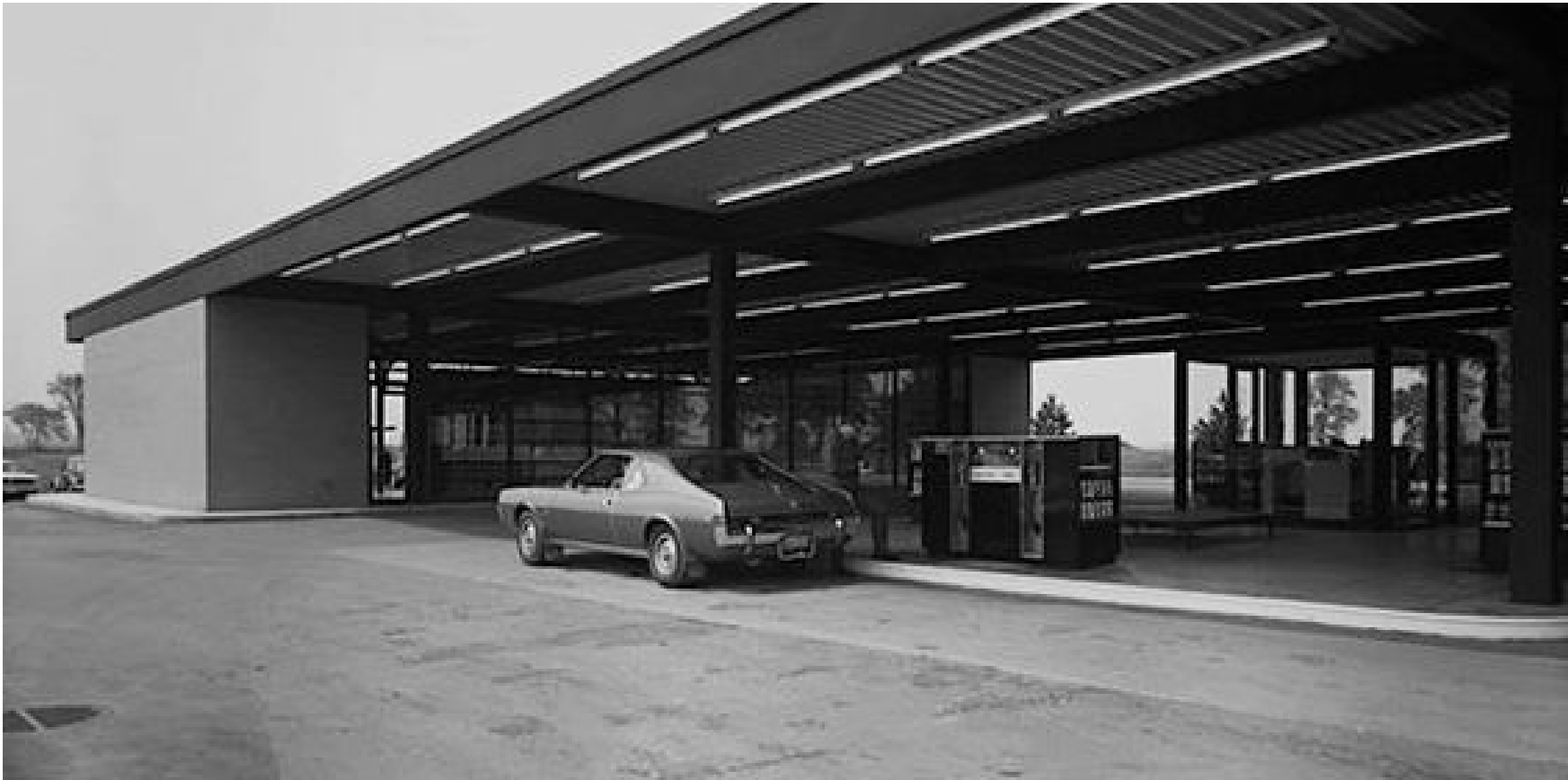
ville montreal [online]. Čerpací stanice navržena Ludwigem Miesem van der Rohem, postavená roku 1968 na ostrově Jeptišek v Montrealu Dostupné z: ville.montreal.qc
