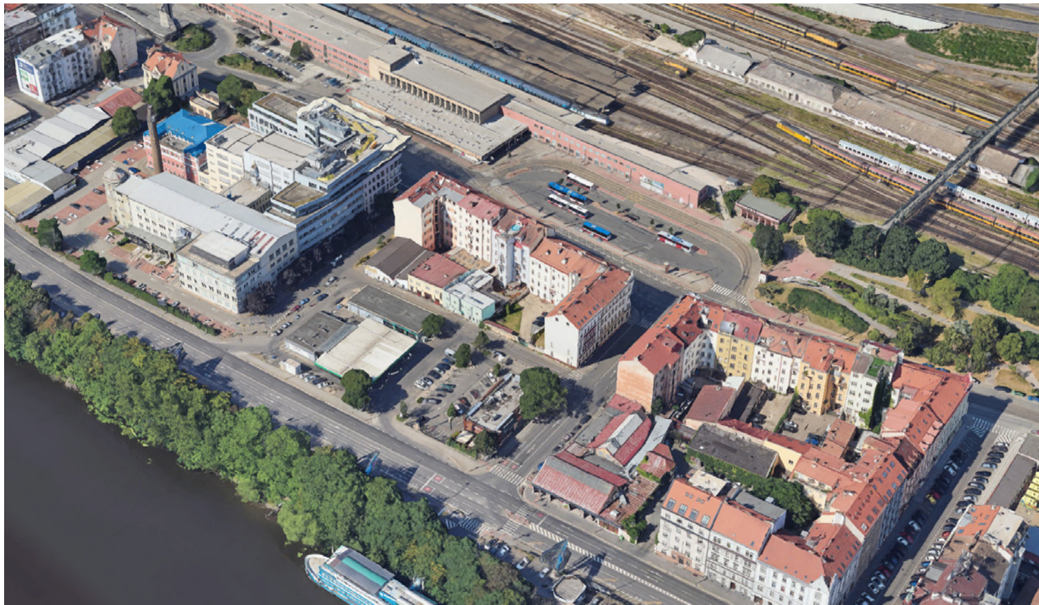
Obr. 1 - Nadhledový snímek řešené lokality
