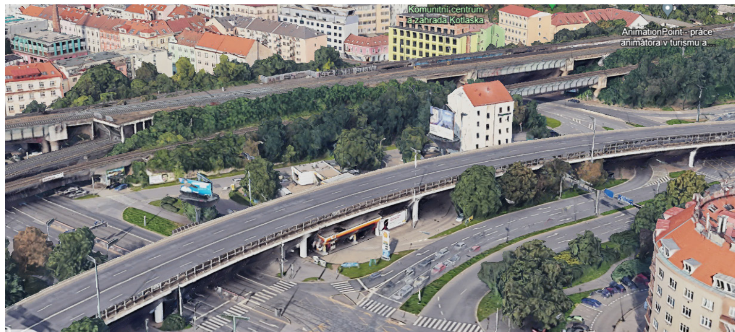
Obr. 1: nadhledový snímek řešené lokality
