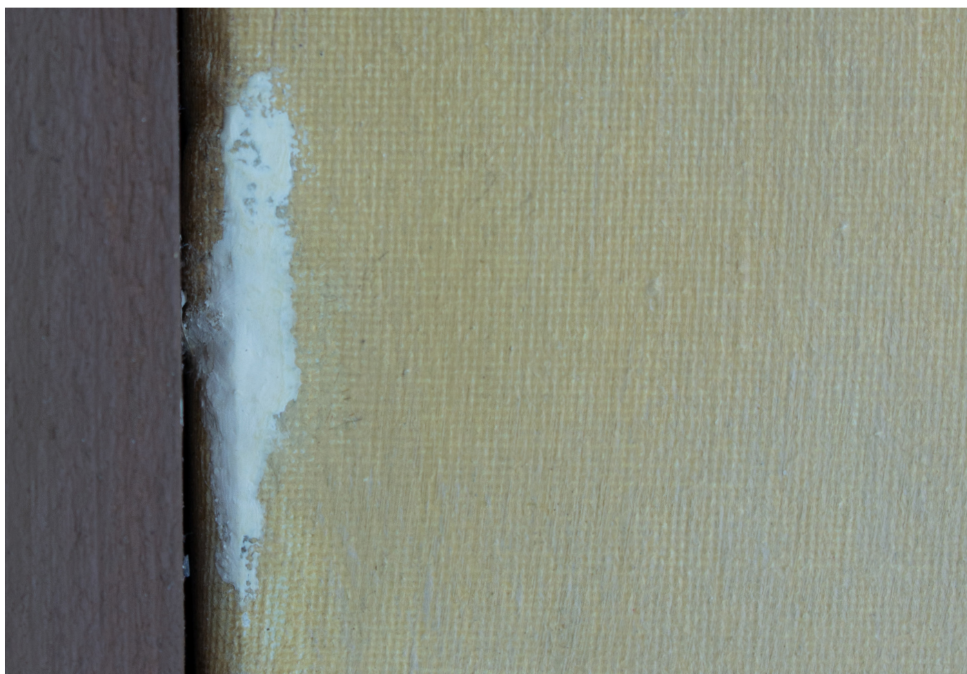
Scelování a tmelení boční menší trhliny
