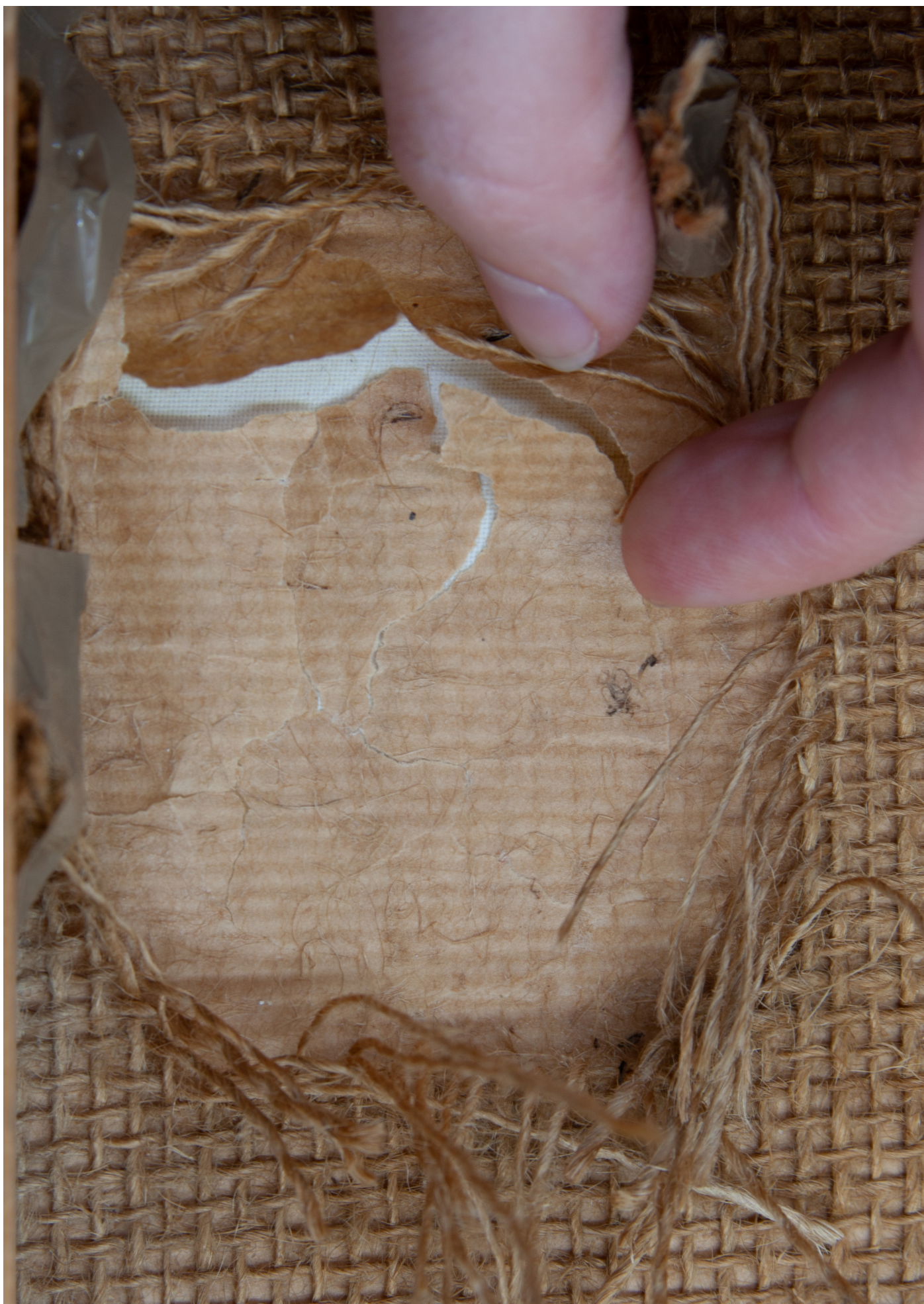
Navracení balícího papíru tvořícího mezivrstvu v podkladu nad scelenou trhlinou do původního stavu
