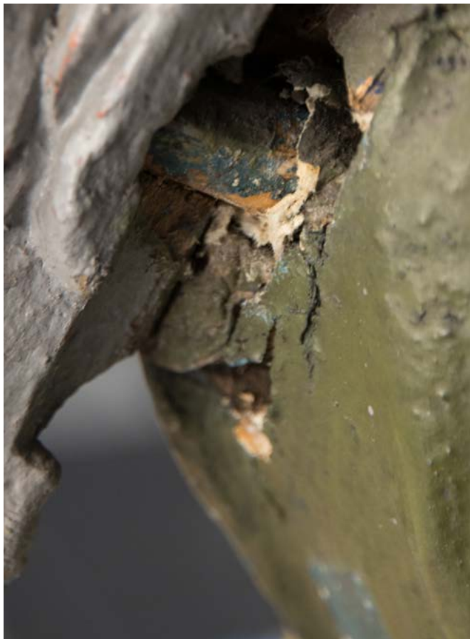
postupné rozobratie nevyhovujúceho druhotné uchytenia krídla krídlo nedrží pevne na mieste, ale hýbe sa v istom rozsahu
