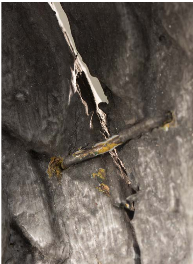
nevyhovujúce druhotné uchytenie dvoch samostatných kusov na ľavom krídle kovovými sponami
