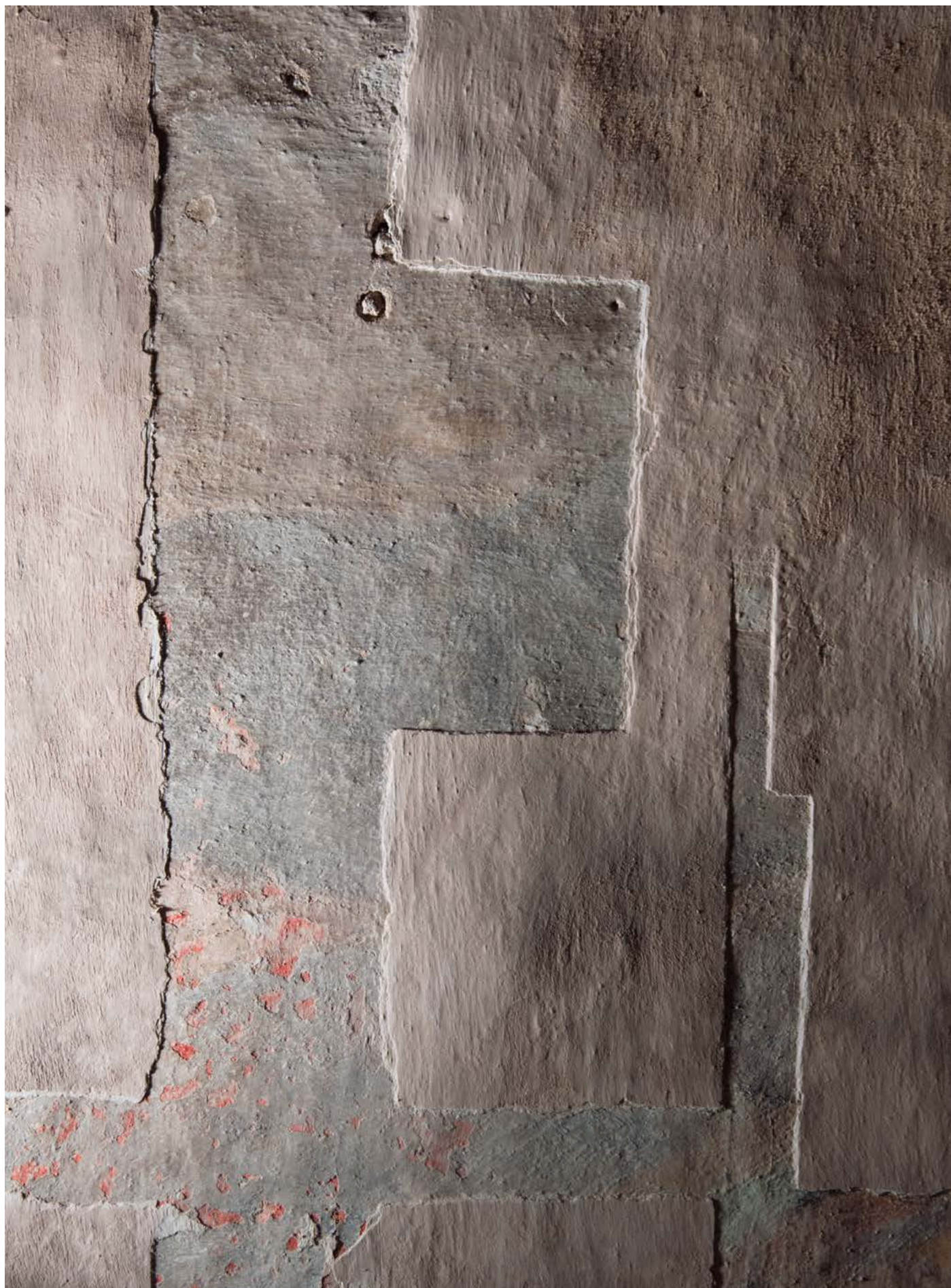
Snímanie postupným rozširovaním sond - mechanické snímanie, razantné bočné osvetlenie
