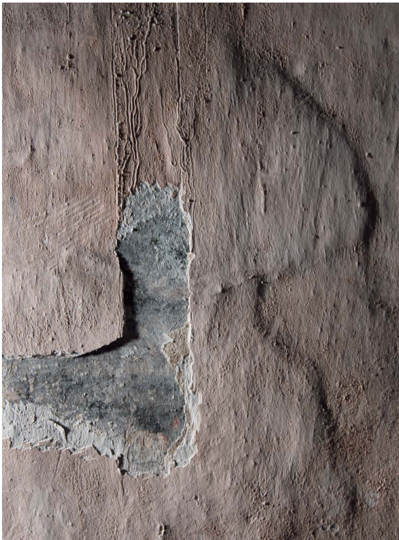
Snímanie postupným rozširovaním sond - mechanické snímanie, razantné bočné osvetlenie detail s razantným osvetlením, kde možno sledovať nerovnosti vo vrstvách omietky
