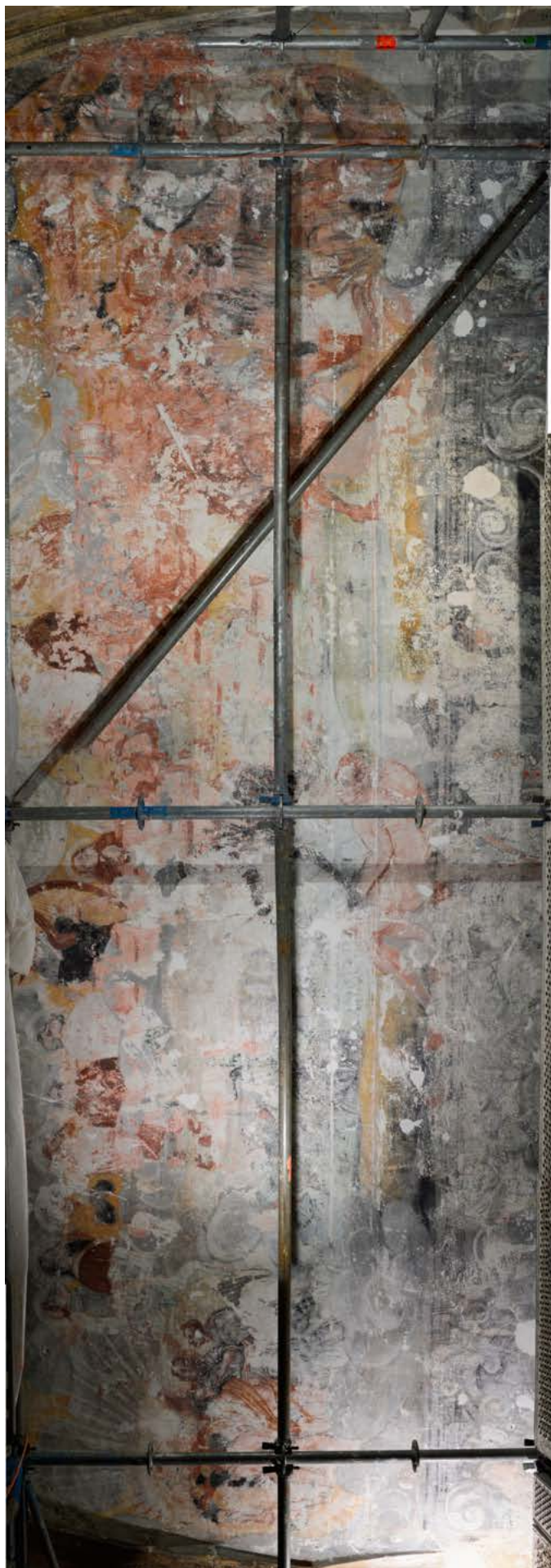
Stav po dočistení vápenného zákalu, výkvetov plesní a po tmelení, celok VIS + razantné bočné osvetlenie
