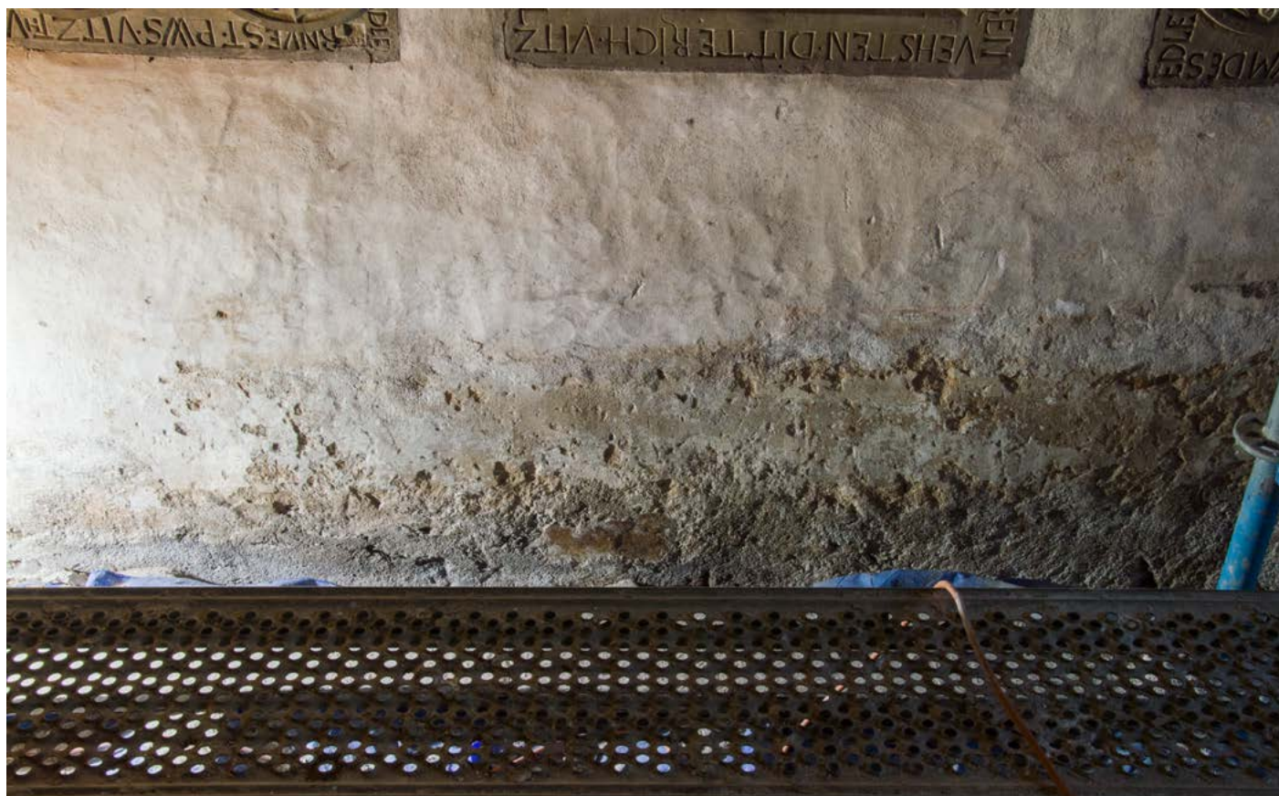
Stav po odkryve, detail , spodná časť steny (pod náhrobkami) súvisí s výmalbou z roku 1614, no už bez farebnej úpravy defekty, peky v stene
