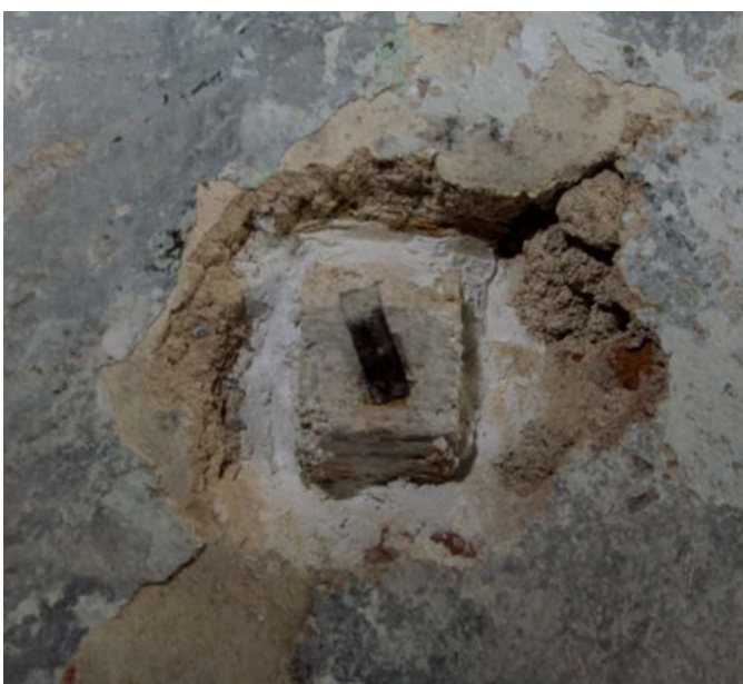
Detail defektov v miestach kde boli osadené konzoly pre elektrické vedenie, VIS postupné odstránenie druhotnej sádrovo dreveno keramickej výplne
