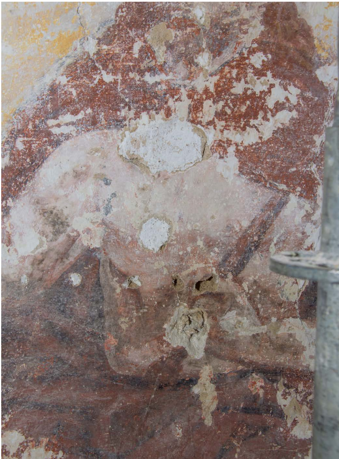
Stav v priebehu odkryvu, detail defektov, VIS, telo Krista druhotné tmely boli odstránené, väčšie kusy muria boli upevnené Ledanom a neskôr dotmelené
