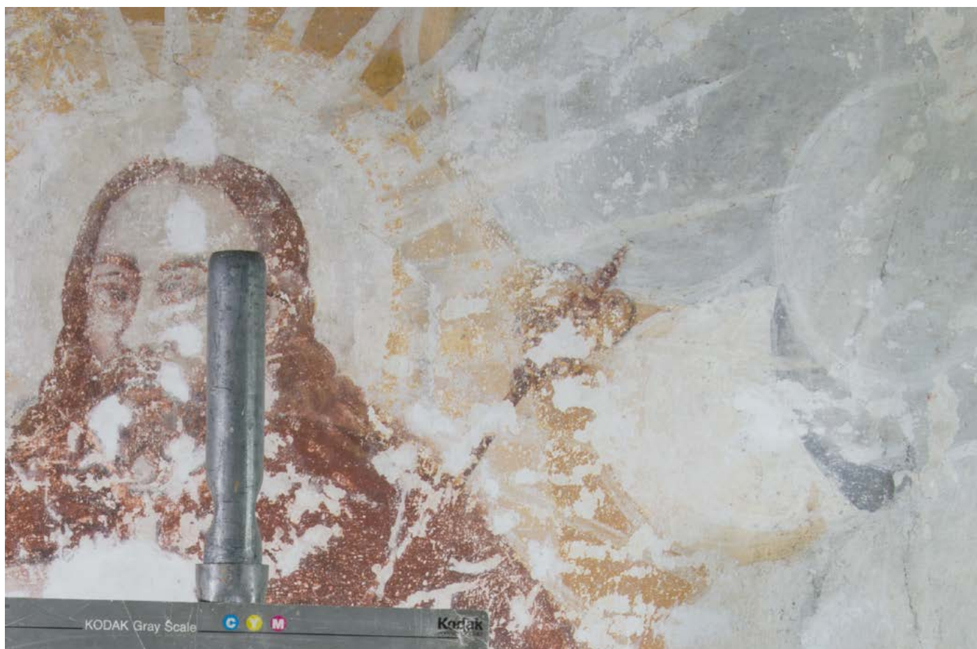
Stav pred a po odstránení vápenného zákalu a plesní (záber je už i stav po vytmelení)
