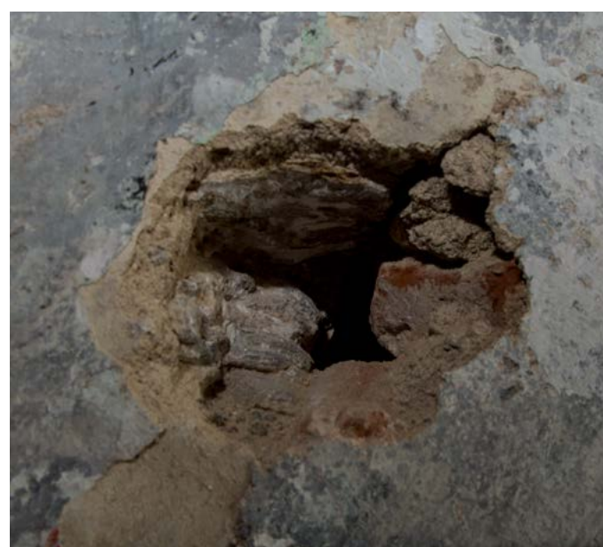
Detail defektov v miestach kde boli osadené konzoly pre elektrické vedenie, VIS postupné odstránenie druhotnej sádrovo dreveno keramickej výplne
