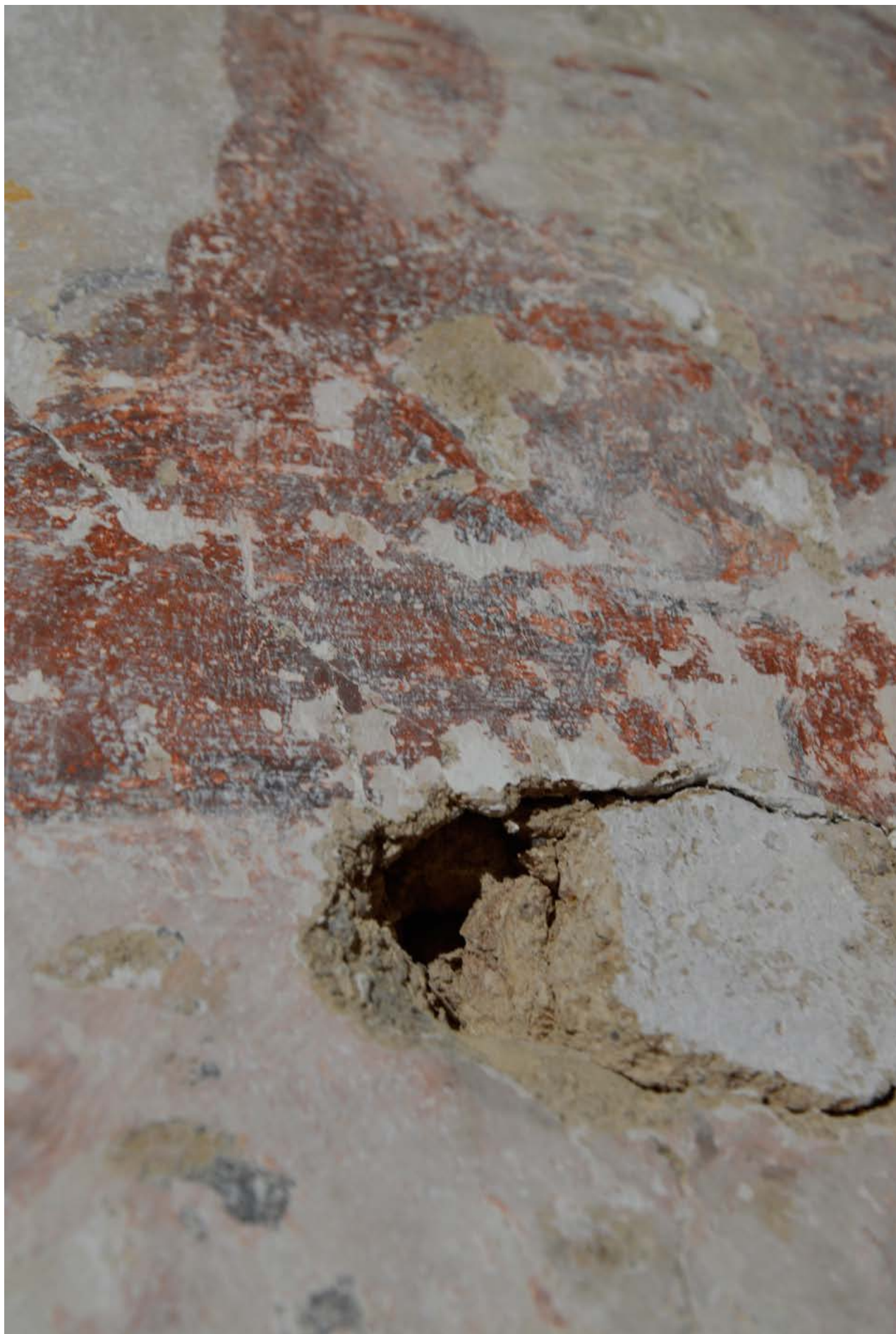
Stav v priebehu odkryvu, VIS, pohľad po odstránení narušenej časti druhotného tmelu,
