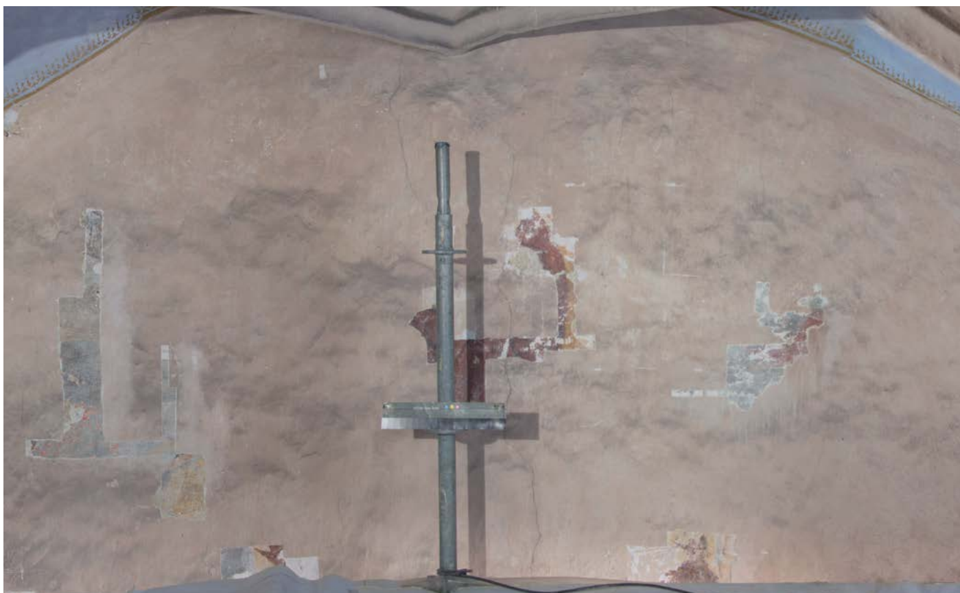
Rozširovanie sondáže - horná časť výjavu VIS
