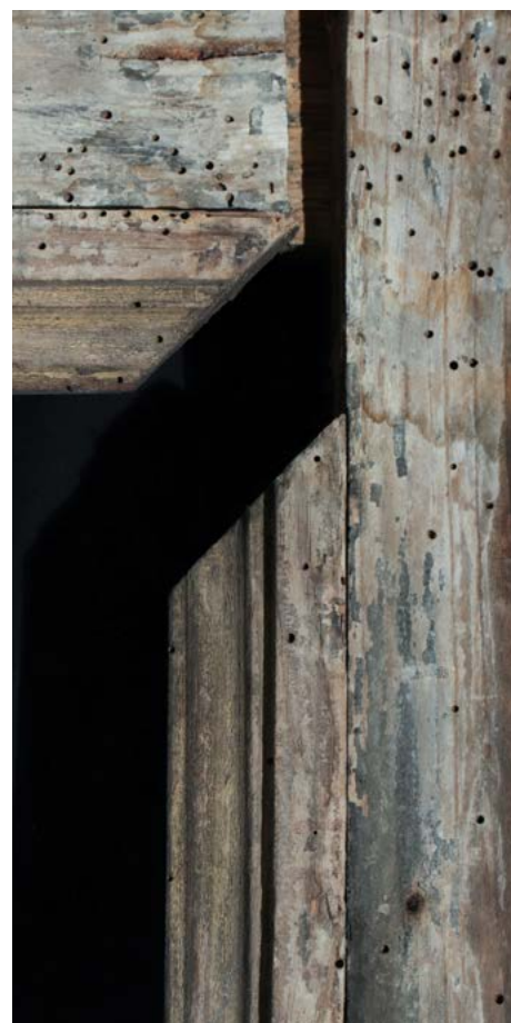
detail - polychrómia rámu s dekorom strany Posledného súdu, minimálne dochované zbytky polychrómie (hore - zľava VIS, razant, UV; dole - detaily; dole vpravo - početné výletové otvory)
