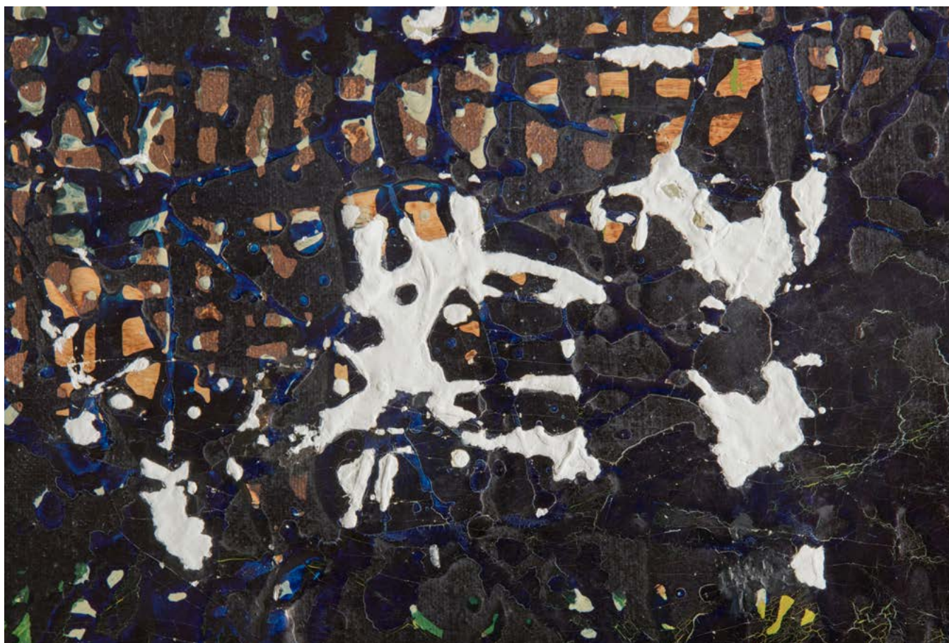
stav po tmelení, detail
