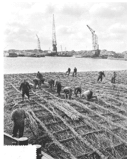
Pletení svazkové podložky z proutí, rok 1956. Zdroj: solar.lowtechmagazine.com/2021/11/fascine-mattresses-basketry-gone-wild
