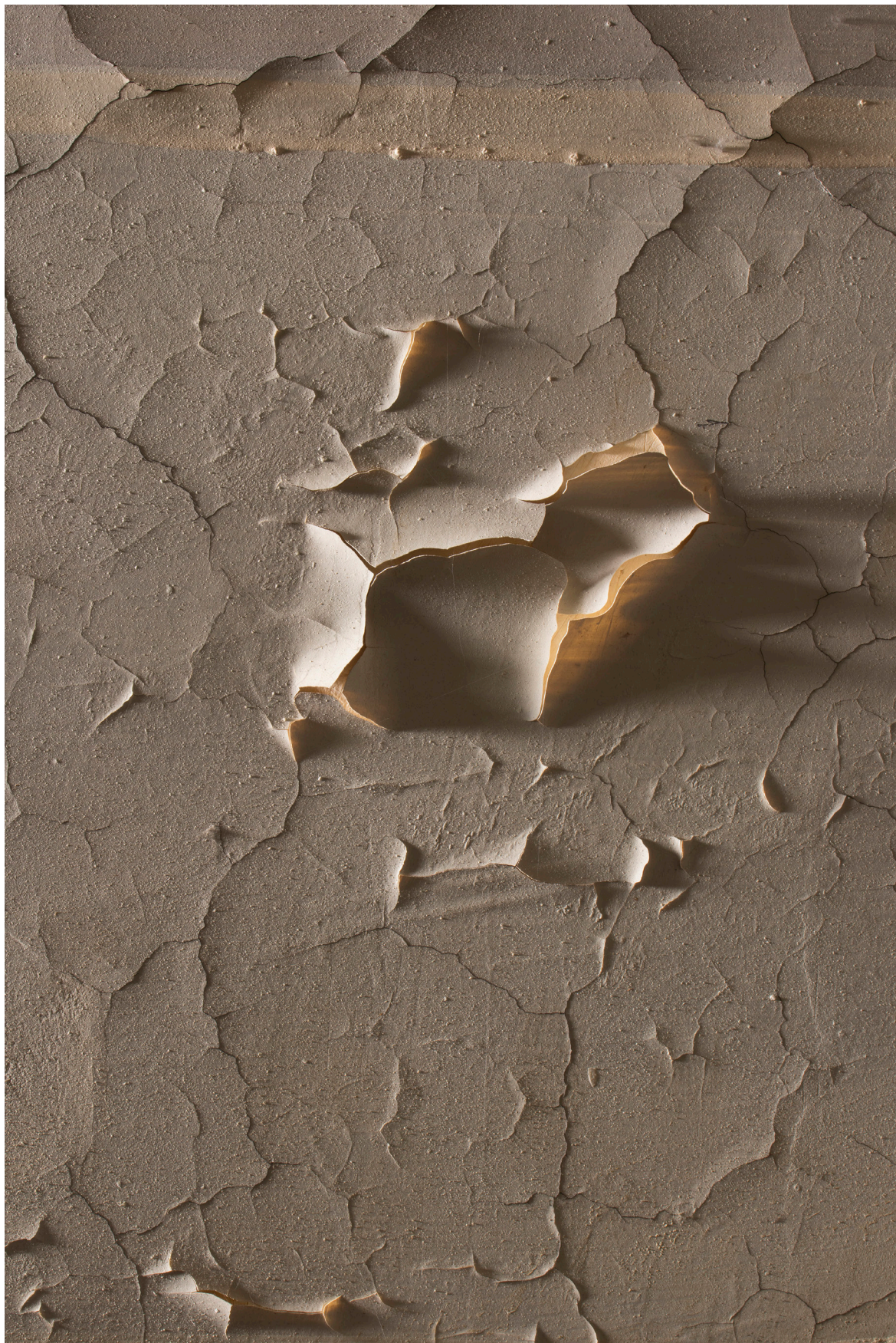
uvolněná barevná vrstva na stěně razantní nasvícení
