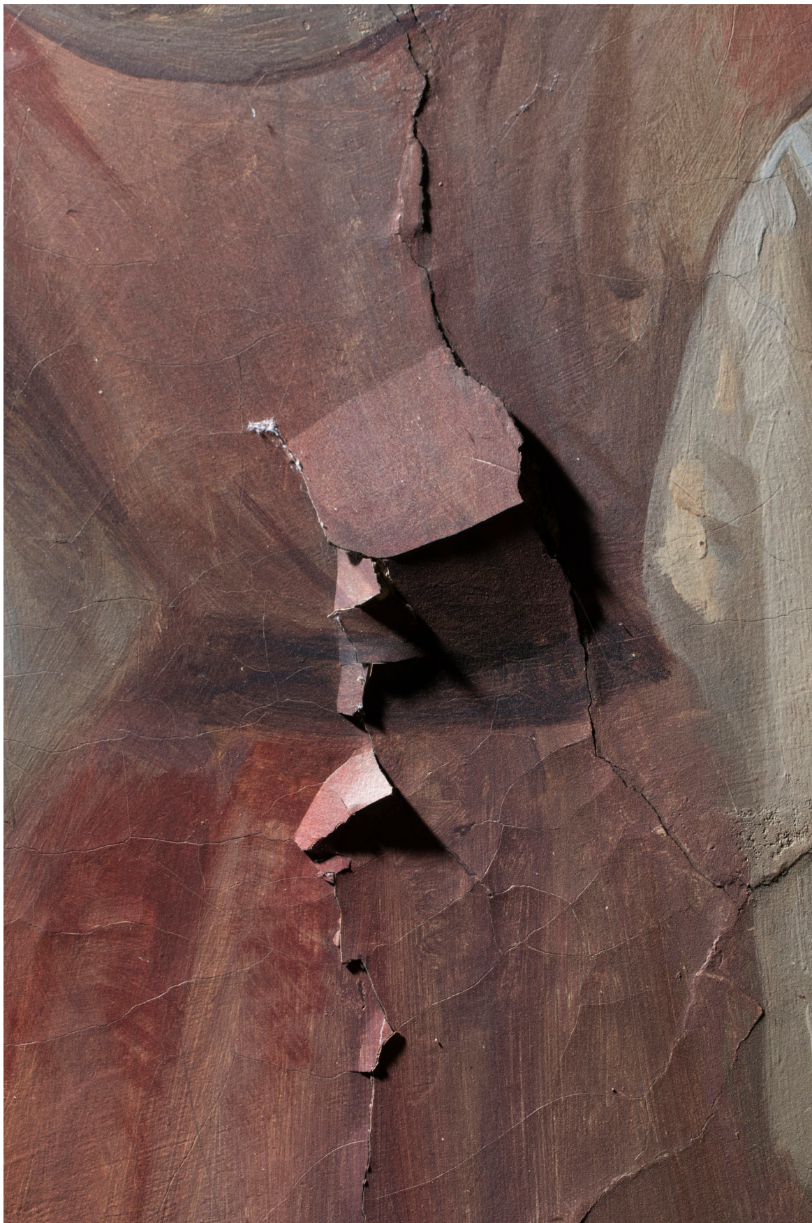
detail uvolněné barevné vrstvy a intonaka razantní nasvícení
