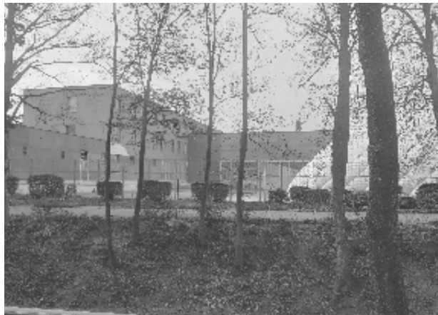
stávající stav / pohled z Grébovky
