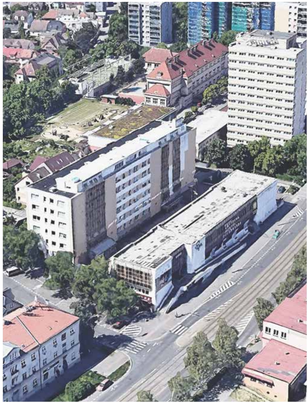
současný stav / severovýchodní strana
