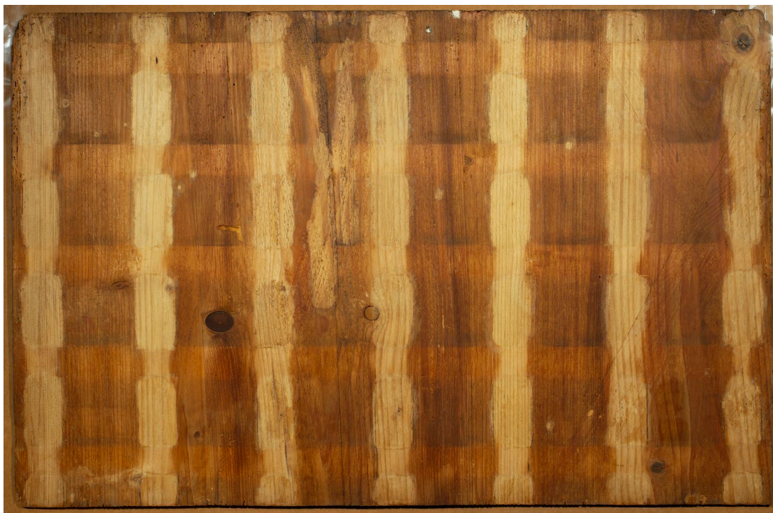
Stav po odstranění parketáže VIS
