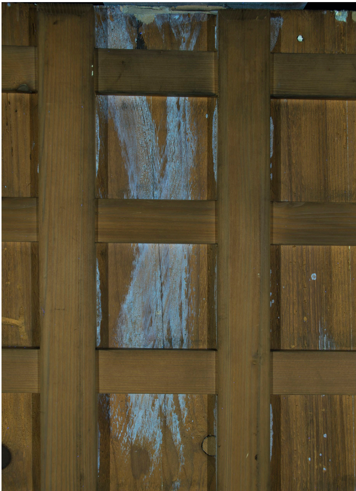
Detail největší praskliny dřevěné podložky UV luminiscence
