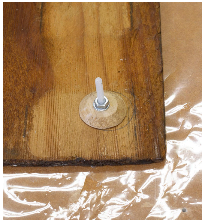
Přiložení tortelliny nastřed označeného místa, vyznačená obvod tužkou
