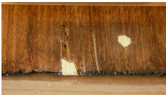
113, 114 - Ztenčení a odstranění zbytků parketáže pomocí syntetického jílů Laponitu RD
