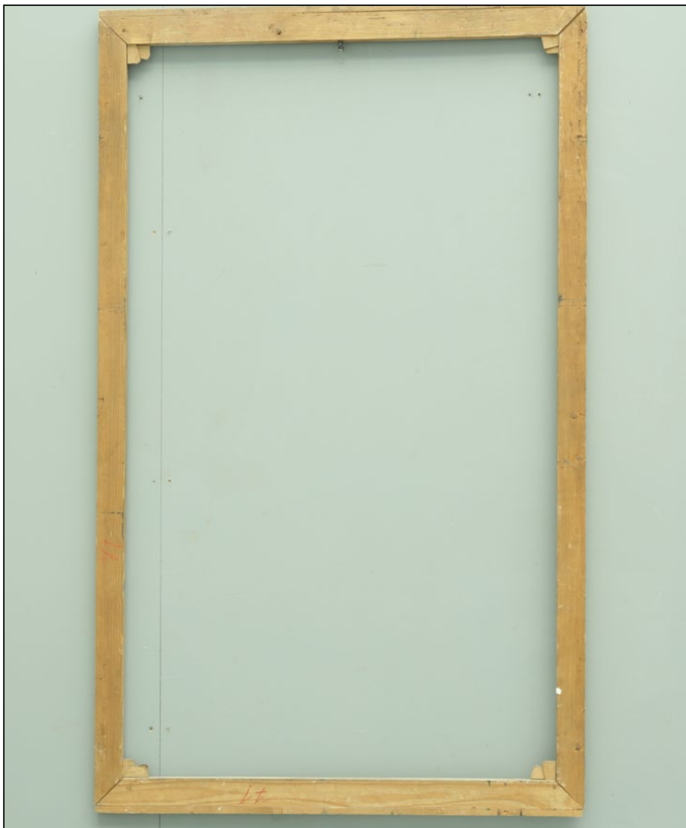
Dřevěný spodní vypínací obrazový rám Rám s možností dopnutí v rozích s oboustraným pokosovým spojem a dvojím klínkováním Rámová lišta je po obvodu zvýšená na bočních lištách pomocí přidané laťky Zadní strana
