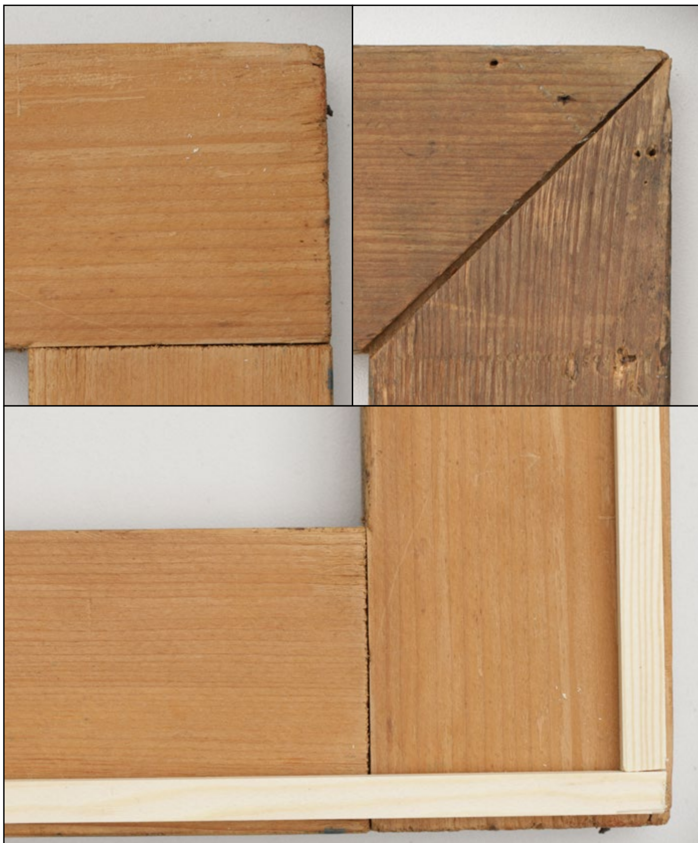
Detail překlátovaného spoje vzadu na pokos před úpravou Detail úpavy vnitřní strany rámu
