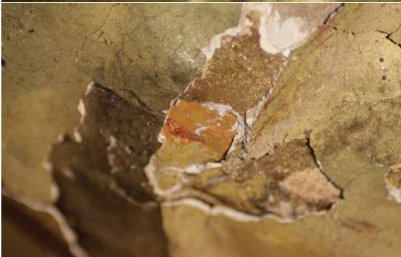
Detaily uvolněných polychromních vrstev
